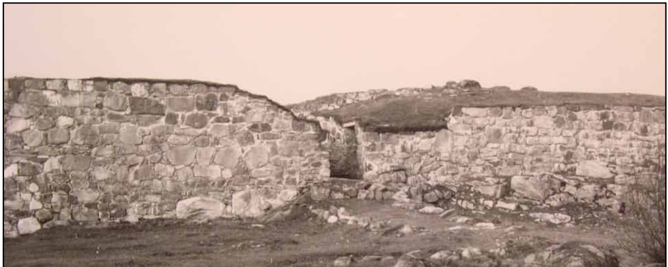
Tre fotografier som visar ruinen i sitt konserverade skick efter arbetena 1936-38. Stora delar av murverken i nordväst och sydosr inklusive västra hörnet är nedtagna och återuppmurade samt påtagligt förhöjda med rasmaterial till trolig ursprunglig höjd samt avtäckta med torv. ATA.
