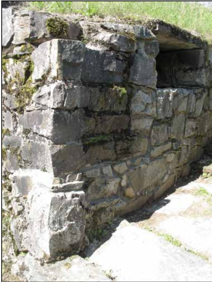
Ovan vänstra sidan av trappuppgången efter ommurning av nedersta skiften. Nedan den högra sidan efter motsvarande insats.
