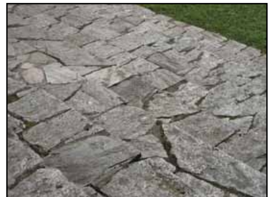
Den lagade paradtrappan.
