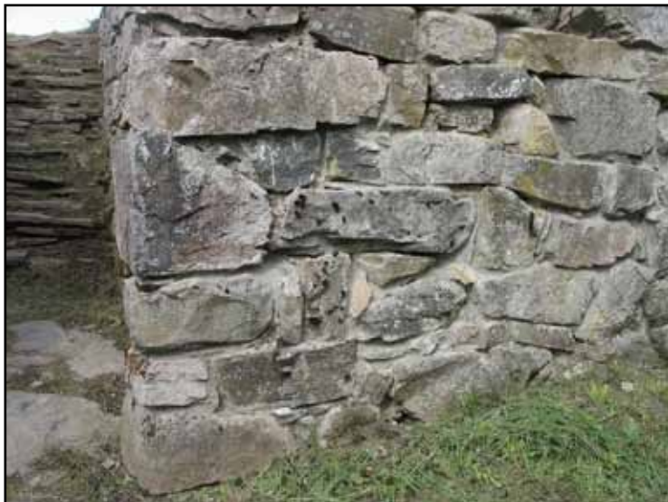
Ovan vänstra sidan av trappuppgången efter ommurning av nedersta skiften. Nedan den högra sidan efter motsvarande insats.
