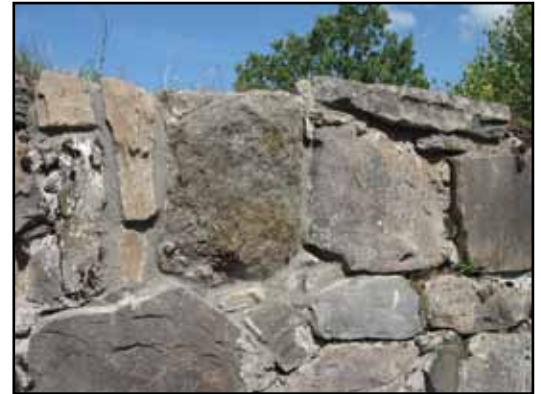
Utfallna stenar har återmonterats i krönet.
