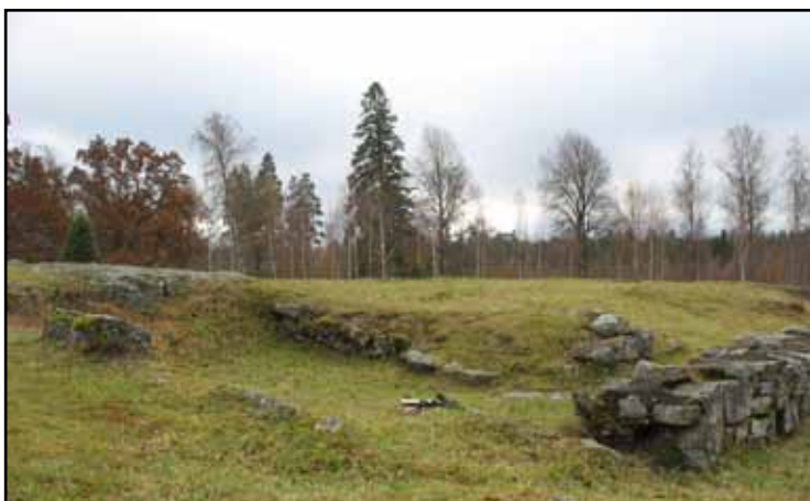
Borghuskällarens murar från norr. Den borte stödmuren har kalvat ut.
