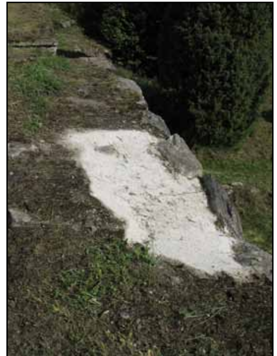
Skadad krönavtäckning av cement har fyllts i med ny cement.
