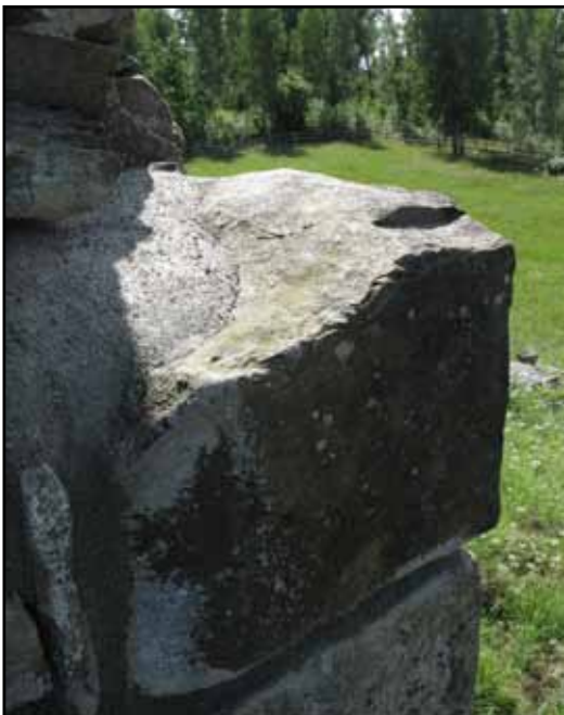
Sten i det norra hörnet har säkrats och försetts med brukspåslag för bättre vattenavrinning.
