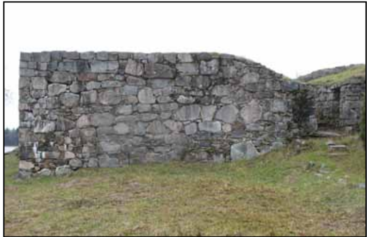
Västra hälften av sydöstra ringmuren.
