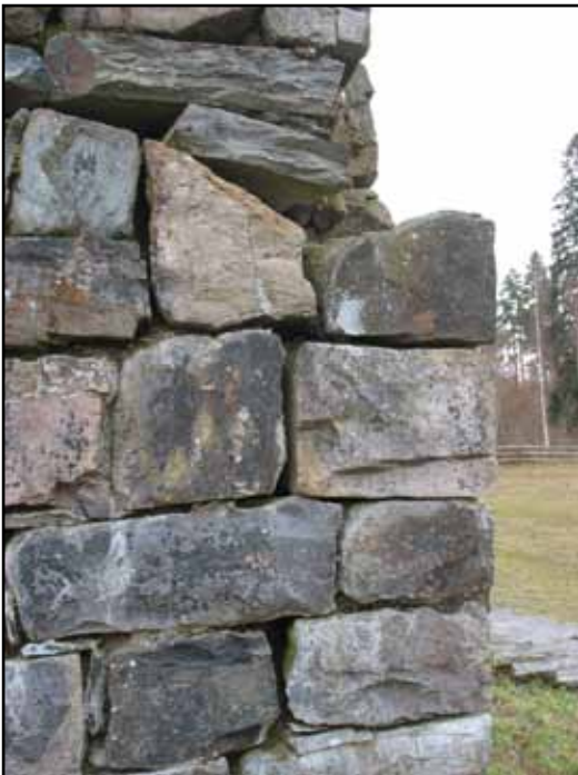
Lös hörnsten i västra hörnet. Till höger i bild murparti med stort bortfall av fog och skärvsten.
