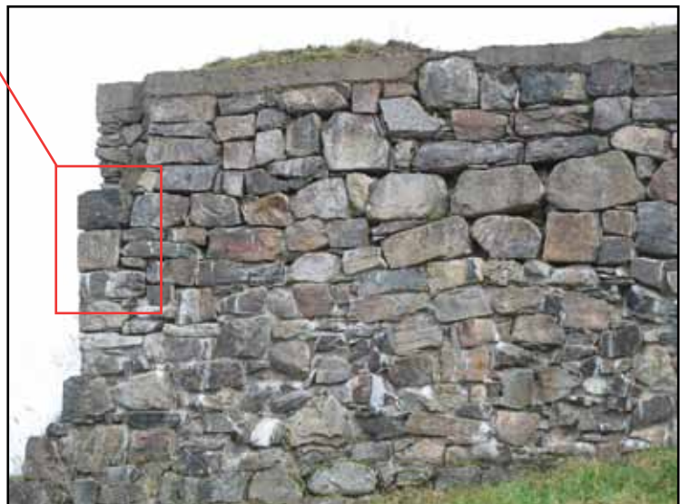
Lös hörnsten i västra hörnet. Till höger i bild murparti med stort bortfall av fog och skärvsten.
