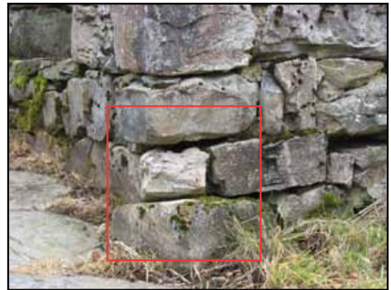
Den lilla ingången. Dess vänstra sida har några lösa stenar under nischen och i anslutning till portomfattningen. Ovan lös respektive rubbad sten nederst i den högra portomfattningen.
