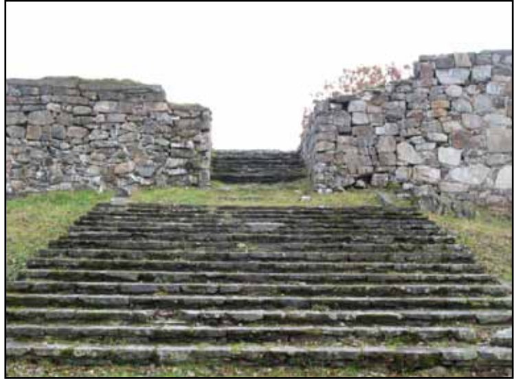
Del av sydvästra ringmuren med paradtrappan av skiffer, vilken rekonstruerades 1936 med lokalt material.
