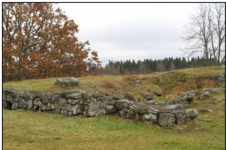
Borghusetets källarsockel sedd från väster.
