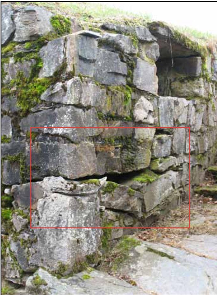
Den lilla ingången. Dess vänstra sida har några lösa stenar under nischen och i anslutning till portomfattningen. Ovan lös respektive rubbad sten nederst i den högra portomfattningen.
