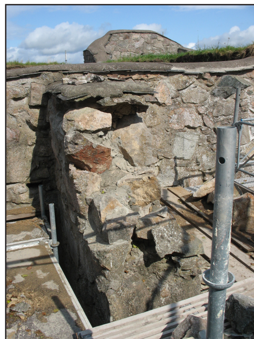
Murkrön mellan västra kabinettet och salen under ommurning.
