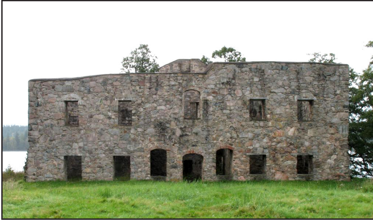
Slottsruinens nordfasad före restaurering.
