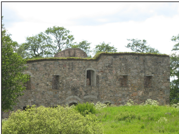
Nordfasaden i restaurerat skick.
