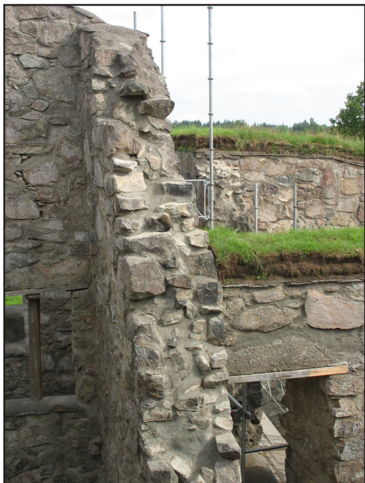
Trapphusets raserade östra vägg efter ommurning av de tidigare till stor del lösa stenarna längs raskanten.
