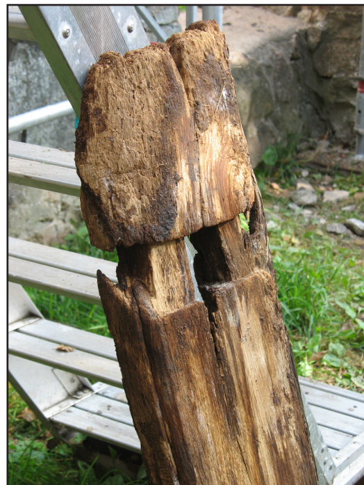
Del av överliggare i ek från på 1700-talet igenmurad dörröppning i andra våningen.
