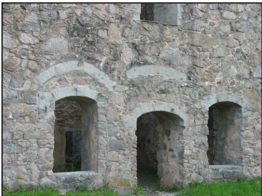
Allt exponerat tegel har slammats tunt för att förhindra frostsprängning.
