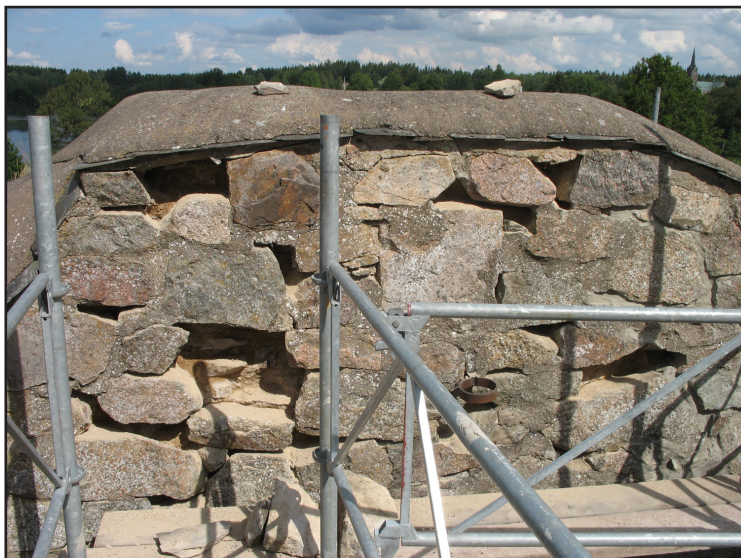
Krönet på trapphusets norra vägg inför omfogning med partiell ommurning av fasadsten.
