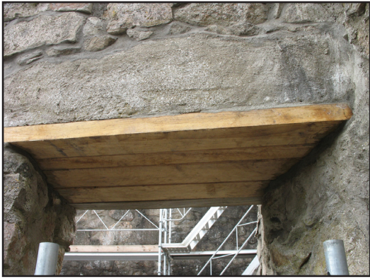
Nya ekplank över en av de invändiga dörröppningarna i andra våningen.
