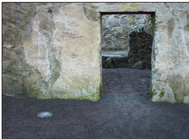
Markarmatur och stensmjöl i hallen och trapphuset.
