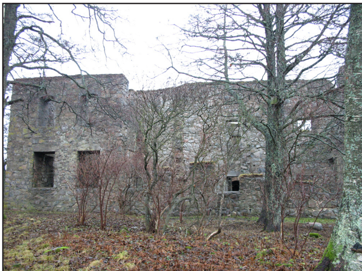
Södra fasaden efter restaurering.
