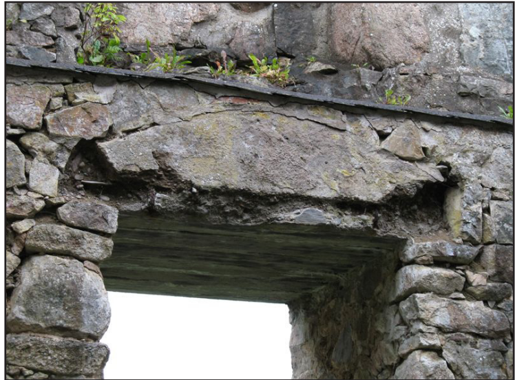
1930-talets betonggjutningar över fönstren hade överlag stått sig väl, men behövde i några fall åtgärdas.
