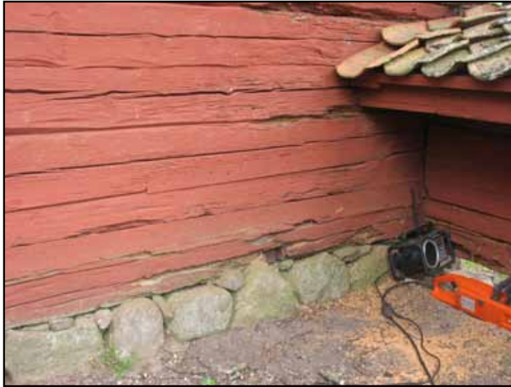
Rötskador på bårhusets nordsida och svampangrepp i hörnet mellan bårhusets sydsida och balken.
