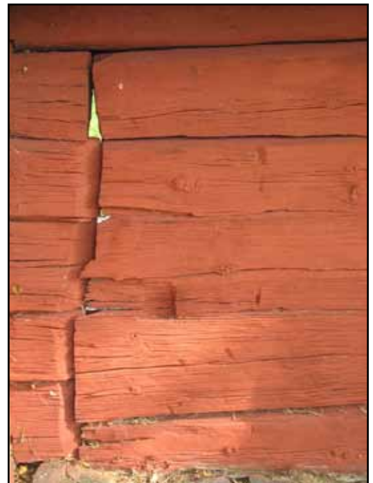
Kilformig skarv i sektion 13, troligen bland det äldsta materialet i de västra balkarna.
