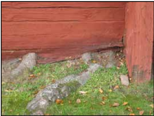
Rötter och fuktiga löv från bokarna har även orsakat rötskador och sättningar i balkarna på östra sidan.
