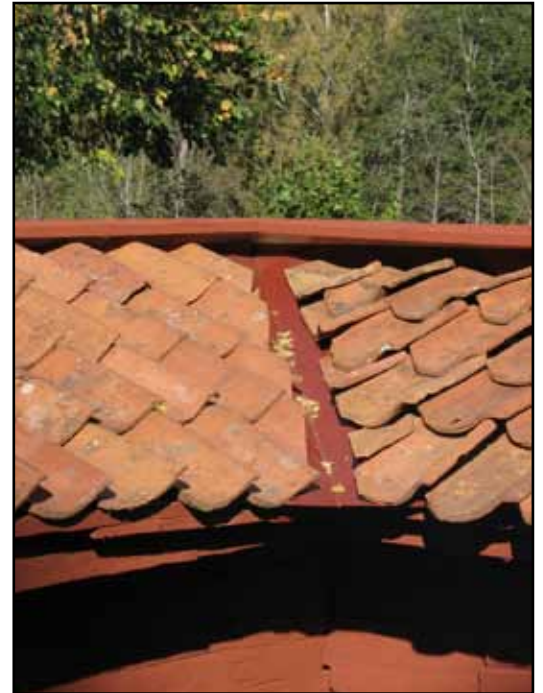
Ovan till vänster: äldre hörnplåt i gott skick aparades. Ovan till höger: på denna plåt lades en ny rännal målad i rött för att harmoniera med timmer och tegel.
