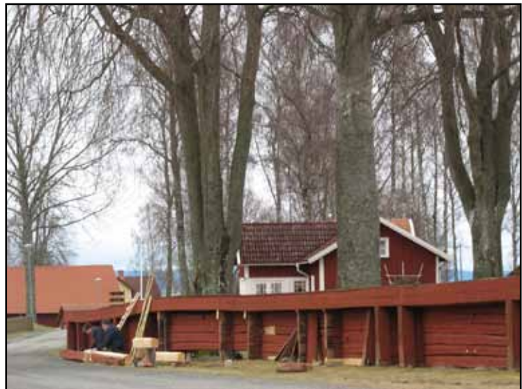
Arbete pågår på de norra balkarna, vilka i öster hade flera skadade syllar.
