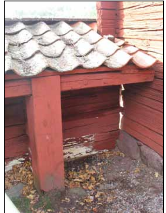
Rötskador på bårhusets nordsida och svampangrepp i hörnet mellan bårhusets sydsida och balken.
