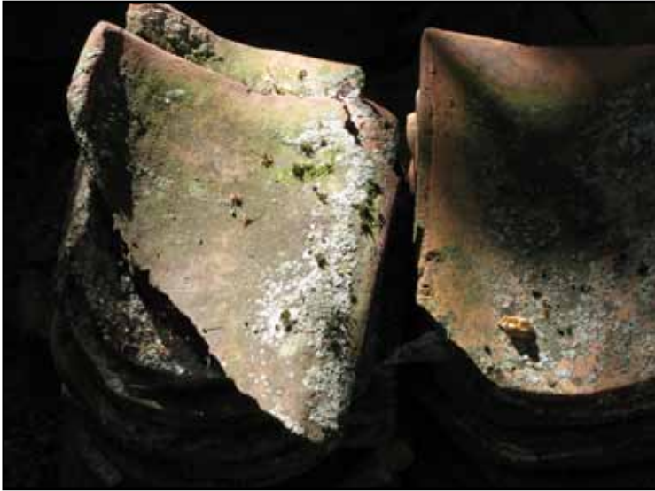
Det handslagna 1800-talsteglet på balkarnas tak plockades ned, tvättades för hand och återlades.
