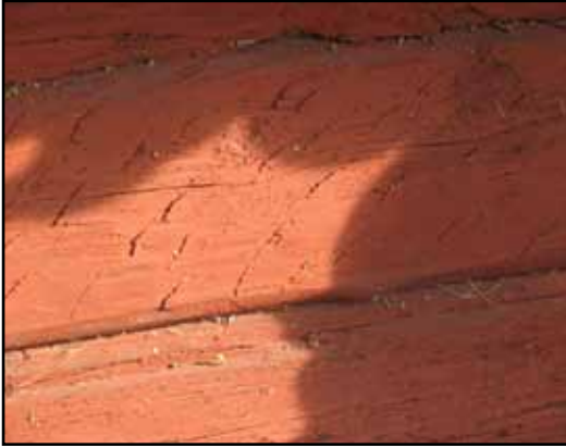
Exempel på återanvänt timmer i de norra balkarna, spår av revetering och urtag för stödben till takstol. Balkarna är i sin tur flyttade från kyrkogårdens södra sida på 1940-talet.
