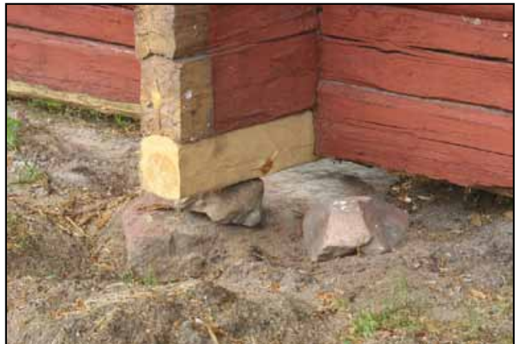
Exempel på byte av knutsyll, en av de vanligaste åtgärderna.
