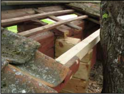
Bilder från östra balkarna och de gamla bokarna som mer eller mindre växt in i dem. Avväxlingar gjordes i den nedre takbjälken.
