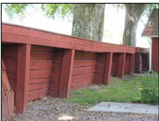
Rötter och fuktiga löv från bokarna har även orsakat rötskador och sättningar i balkarna på östra sidan.
