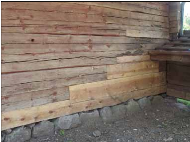
Timmerlagningar på nordsidan av bårhuset.
