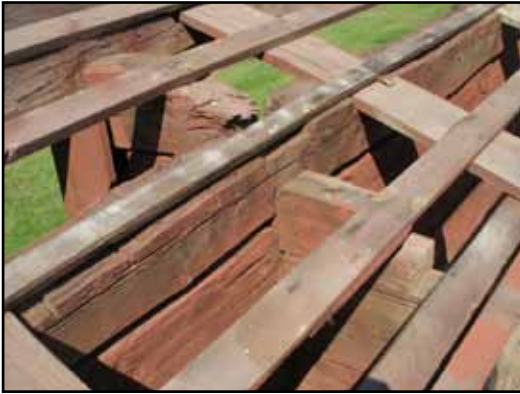
Detalj av möte mellan tak och knut på västra sidan.
