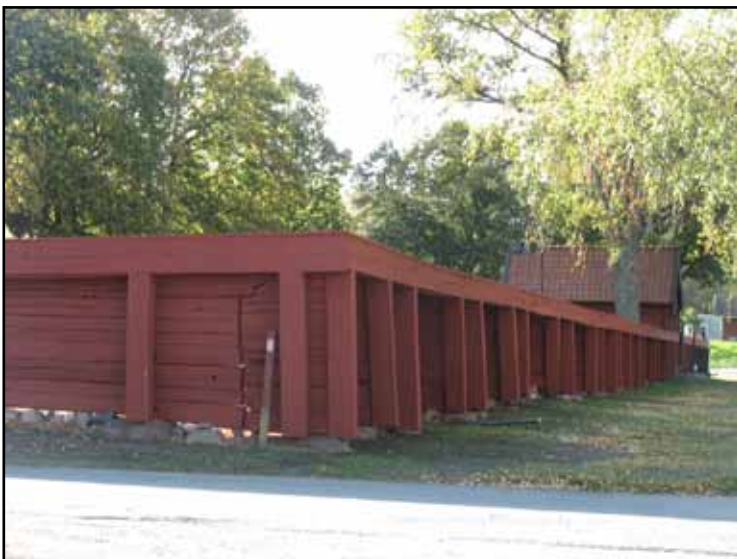
Västra balkarna efter avslutade arbeten.
