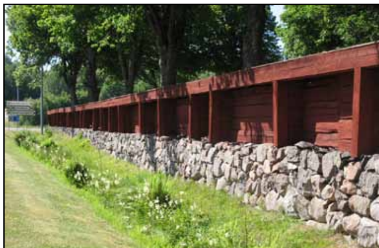
De södra balkarna är timrade under 1940-talet på en nyanlagd hög kallmur. Bortsett från smärre skador och några träd som är nära taket är de i gott stånd.
