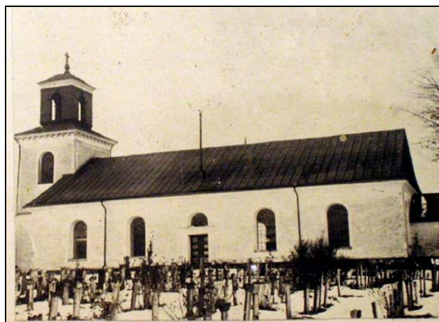
Kråkshults kyrka någon gång mellan 1900 och 1910. De två korfönstren som togs upp 1862 syns här tydligt, liksom evakueringsröret från den ena av de första värmekaminerna. Utvändigt syns både skorstenen och det nya plåttaket som ersatte den ursprungliga spåntäckningen. I övrigt skiljer sig inte dagens utseende från det kring förra sekelskiftet. Foto i kyrkans ägo.
