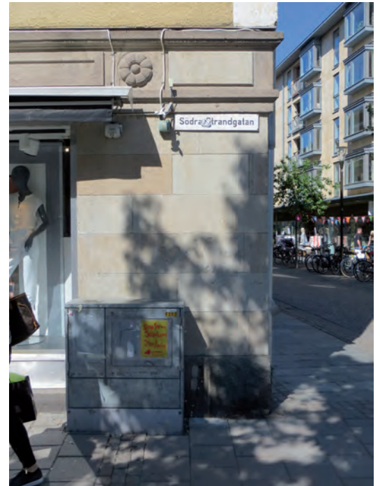
Ovan: Butiksfasaden av kalksten med krön av konststen.
