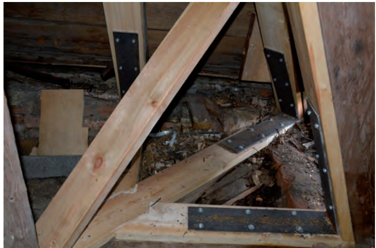
Läckage från rännviden hade lett till svampangrepp i tassarna och högbenen. Nordvästra hörntassen fick bytas i sin helhet. I övrigt förstärktes samtliga tassar och högben med furuplank och smidesvinklar.
