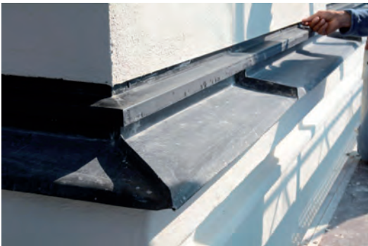
Komplettering av droppnäsa på tornets midjesims med korrekt putskant.
