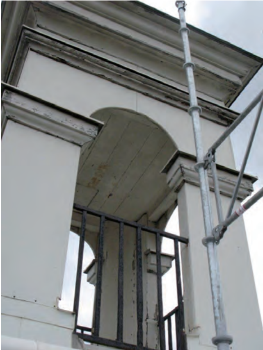
Lanterninen är utvändigt klädd med vit plåt sedan många år. Listverken är målade med en tjock vit alkydjelfärg utan brytning.
