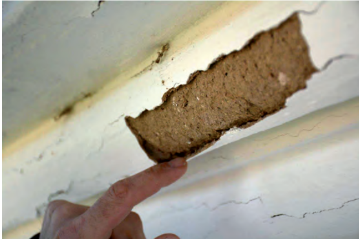
Skador på gesims till följd av läckage från rännal.
