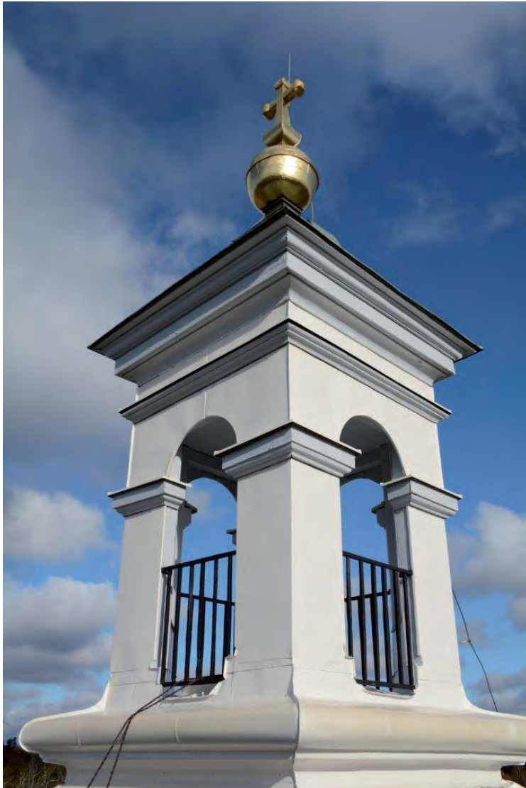
Lanterninen efter avslutade arbeten, med en bruten färgställning som framhäver listverken.
