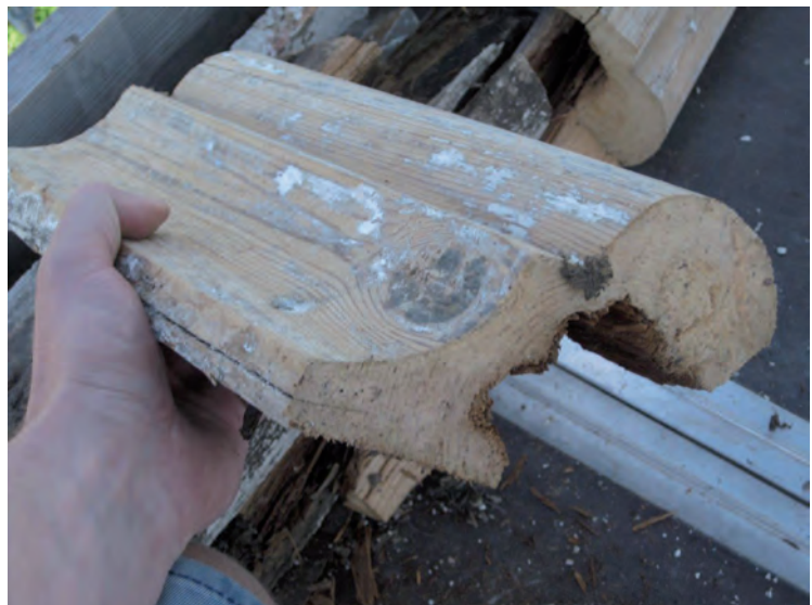
Rötskadad list från lanterninen.
