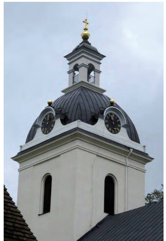
Det nya stupröret monterades utvändigt och målades i fasadkulören.
