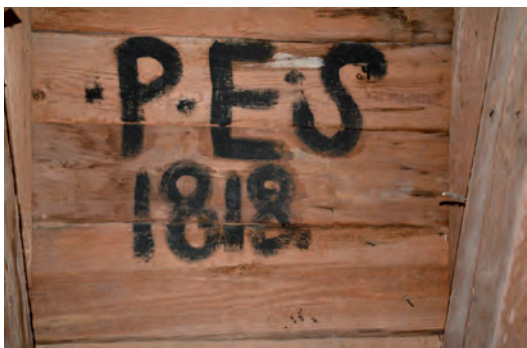
Undertaket i tornhuven bär initialerna P E S och årtalet 1818 målat i svart. Brädorna saknar spikhål efter spåntäckning. Troligen lades det första plåttaket 1818.
