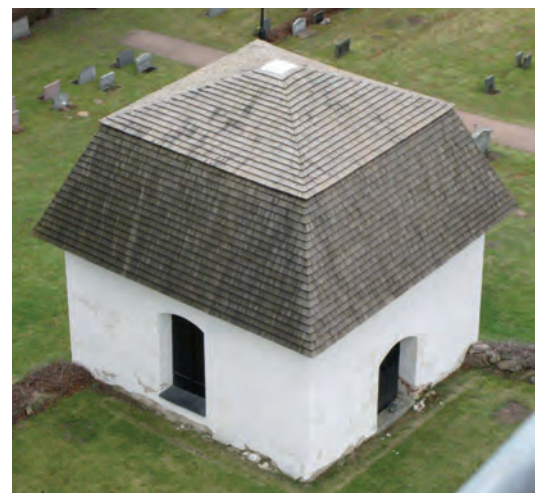
Bogemanska gravkoret. Fasadputsen har bom och bortfall längs marken. Kalkfärgen flagnar fläckvis.
