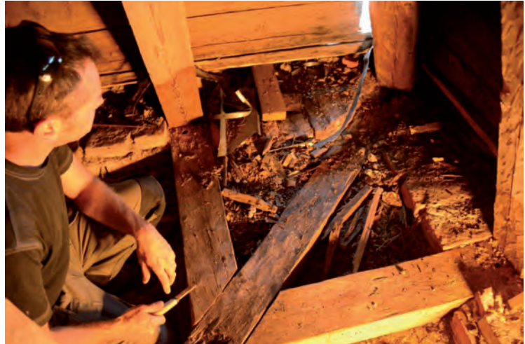
Läckage från rännviden hade lett till svampangrepp i tassarna och högbenen. Nordvästra hörntassen fick bytas i sin helhet. I övrigt förstärktes samtliga tassar och högben med furuplank och smidesvinklar.
