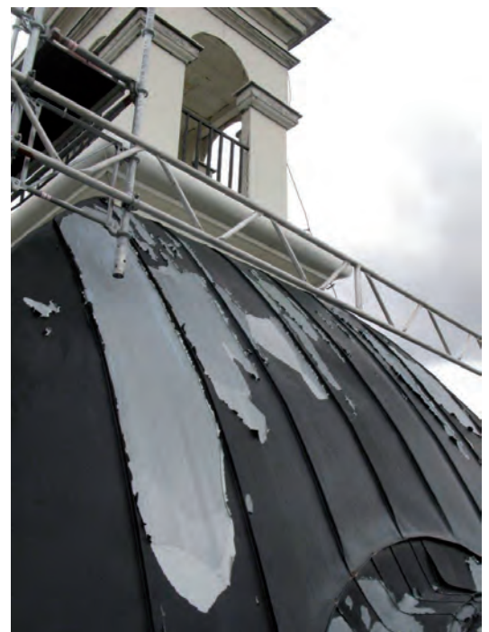
Tornhuvan har bandtäckt plåt från 1992 med fabrikslackad svart plastfärg som nu flagnar av.
