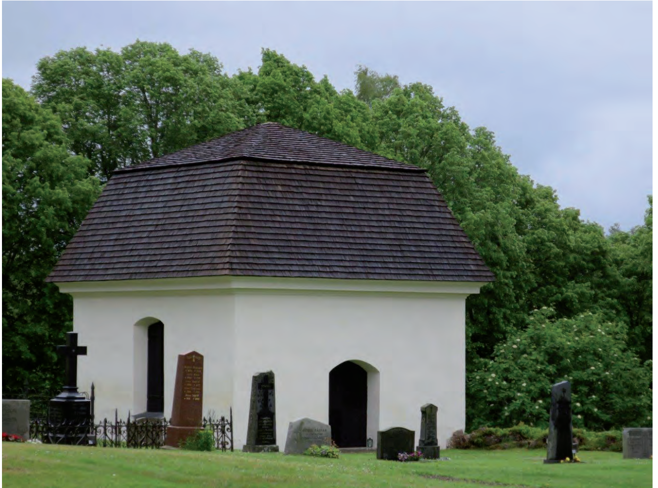
Gravkoret efter avslutade arbeten 2015. Fasaderna målade med silikatfärg i samma kulör som kyrkan. Taket har fått 301 spån utbytt och har tjärstrukits.
