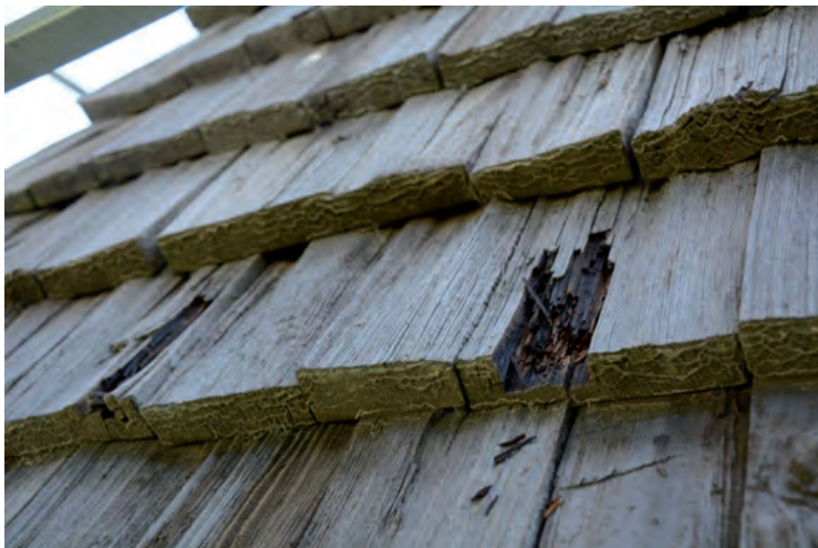
Spridda spån på takfallen var tagna ur ytved och hade därför ruttnat upp.
