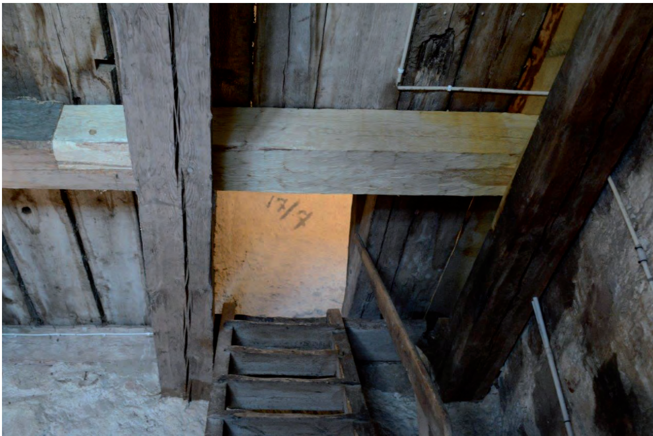
Nytt stycke skarvat i svampangripen bjälke, två golvplankor utbytta liksom trappans ena vangstycke.
