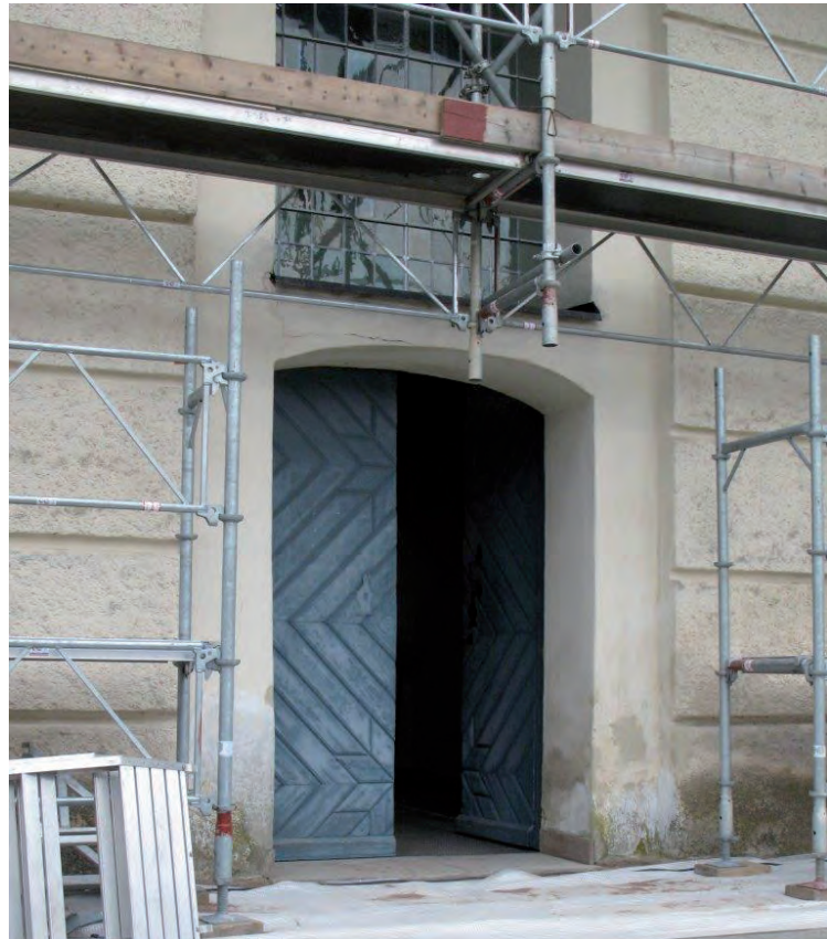
Tornporten. Putsen vid mark och entré är missfärgad och har bom samt färgbortfall.
