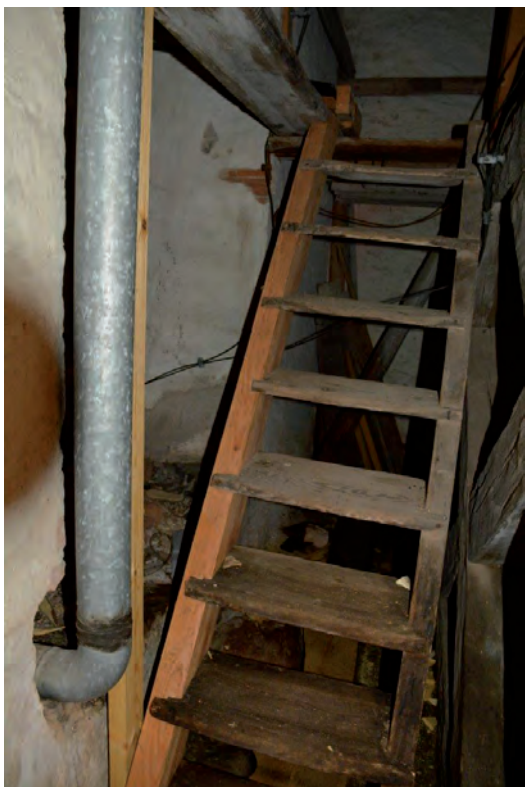
Nytt stycke skarvat i svampangripen bjälke, två golvplankor utbytta liksom trappans ena vangstycke.
