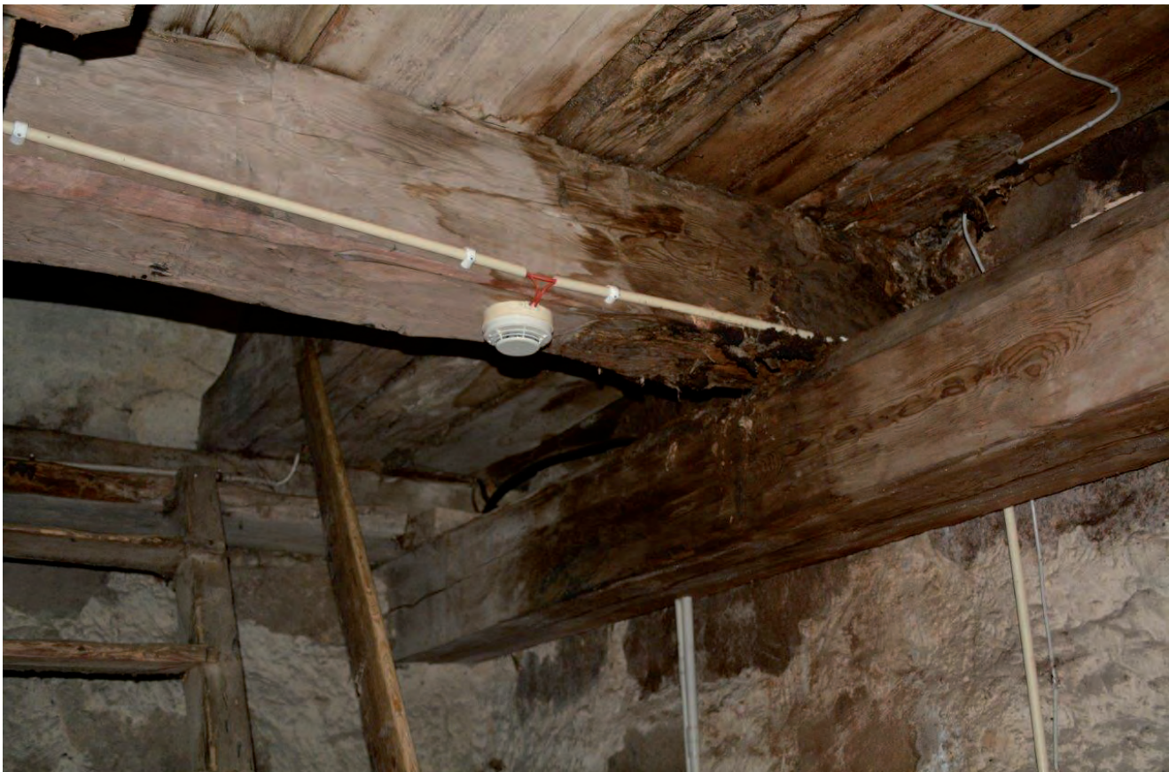
Hussvampangrepp i östra delen av bjälklaget under klockstolen, orsakat av...
