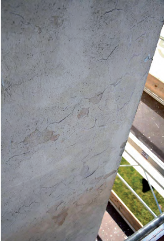
Färgsläpp på tornfasad.
