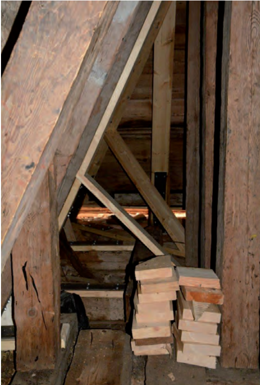
Läckage från rännviden hade lett till svampangrepp i tassarna och högbenen. Nordvästra hörntassen fick bytas i sin helhet. I övrigt förstärktes samtliga tassar och högben med furuplank och smidesvinklar.
