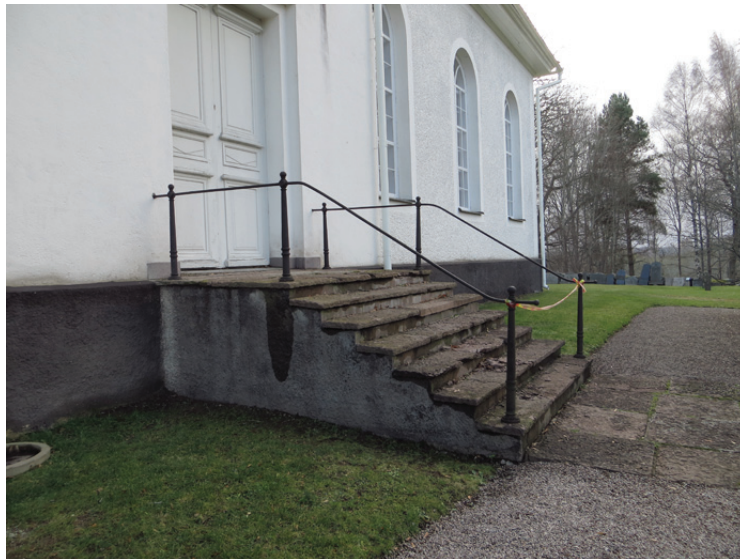
Detalj av den skadade trappan före åtgärd. Vissa steg var vittrade kraftigt.
