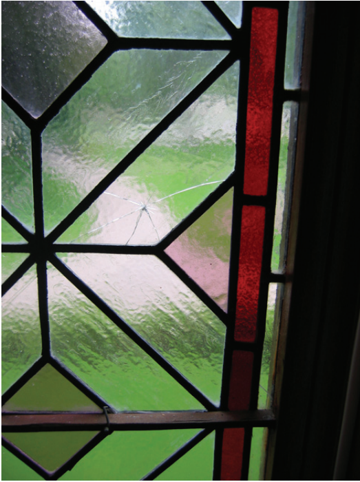
Många rutor var trasiga, troligen orsakade av stenskott från trimmer.
