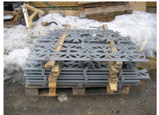
Nocksmidet demonterades och restaurerades på verkstad.
