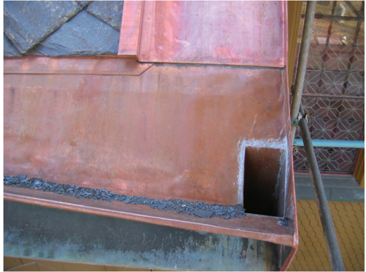
Detalj av omlagd fotplåt och tratt till stupröret, foto från byggmöte april 2005.
