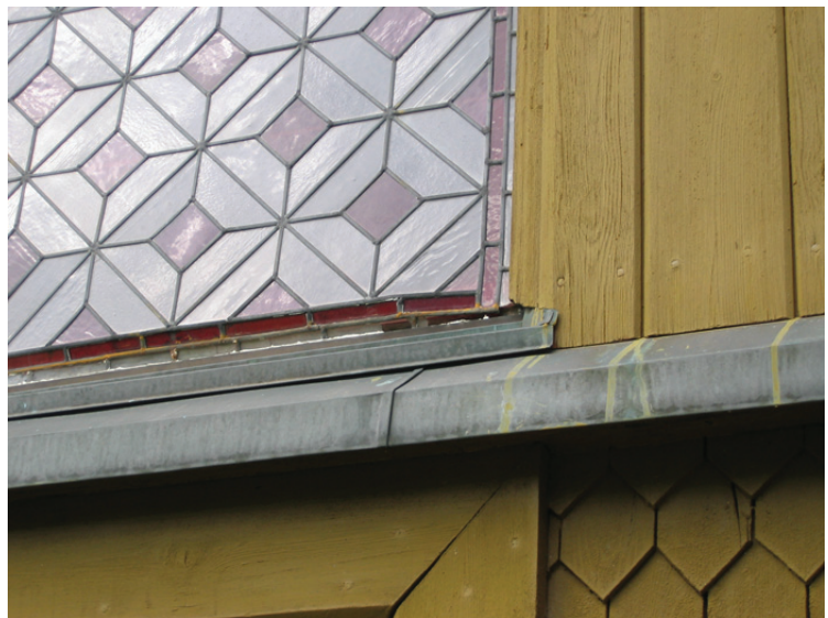
Blyglasfönstren var skadade och de nedre spröjsen trycktes ihop av fönstrets egen tyngd.
