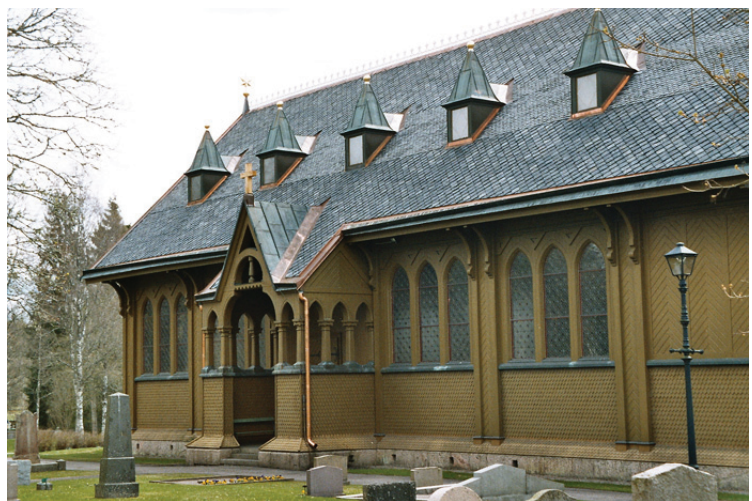
Sydfasaden och korets tak lades om med nytt spanskt skiffer.
