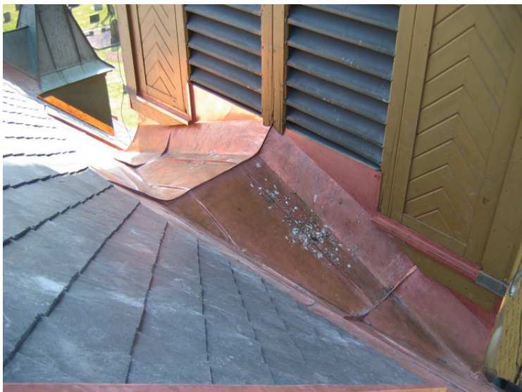
Vinkeln mellan långhustaket och tornet, slutbesiktning.
