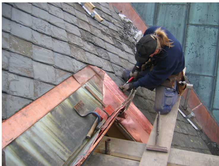
Plåtläggning. Ny plåt fogades samman med äldre plåt i gott stånd.
