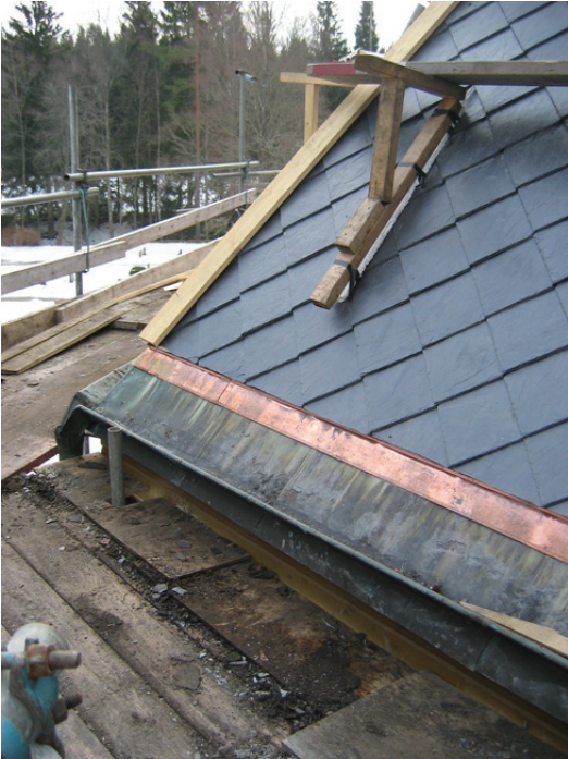
Kompletterande fotplåt. Kortaket med nylagt skiffer, det nya skiffret blir med automatik skarpare i kanterna än det omlagda skiffret.
