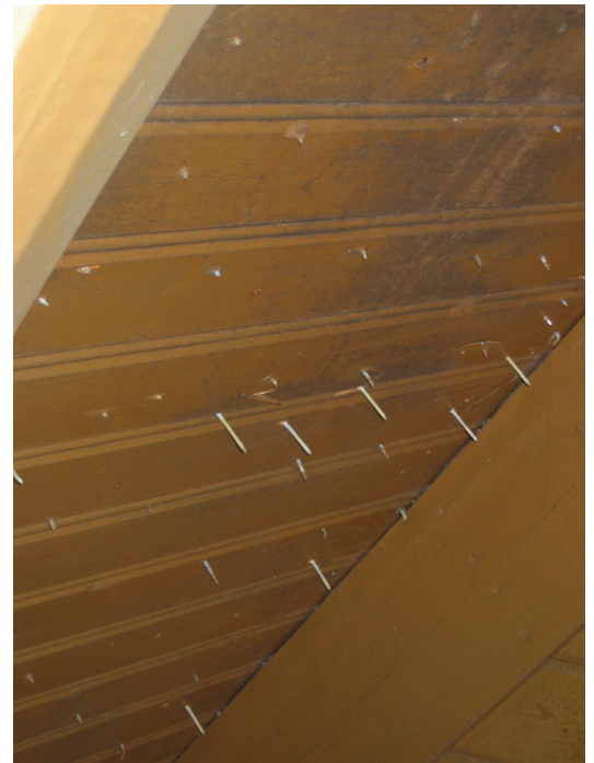
Spikgenomslag i takfoten.
