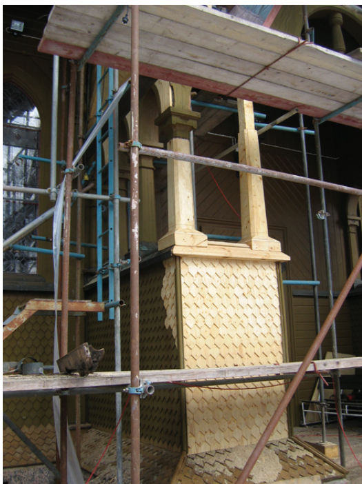
Lagningar av dekorelement västra gaveln.
