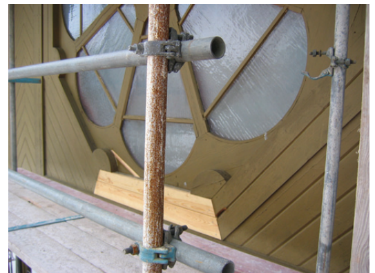
De partiella lagningarna av rosettsfönstrets ramverk och infattning.
