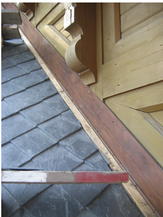
Vid demontering av plåten vid östgaveln mot kortaket blottades en panelbärda med ett äldre färgskikt.
