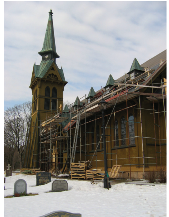
Pågående arbeten på tak och byte av rötskador vid den södra entrén.
