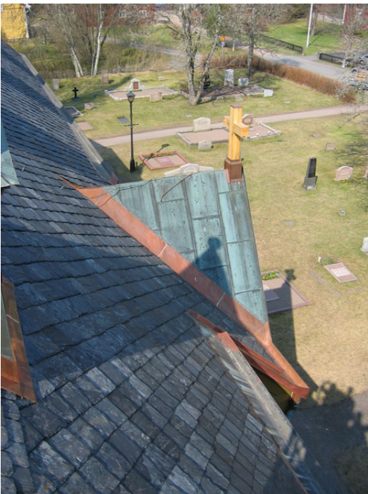
Det norra takfallet vid slutbesiktning, bytta plåtar framträder ännu med tydlighet. Korset som rider över sidoentréns taknock är nyttillverkat.
