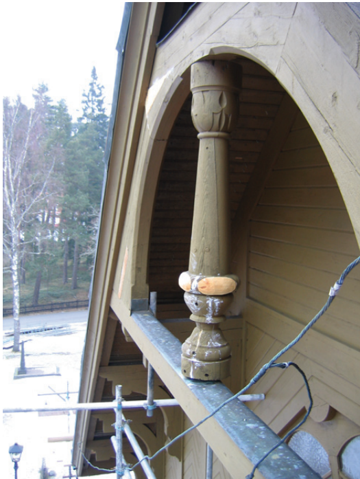
Lagningar av dekorelement västra gaveln.
