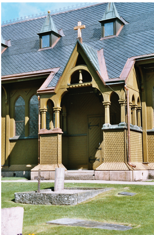
Sydfasaden och korets tak lades om med nytt spanskt skiffer.
