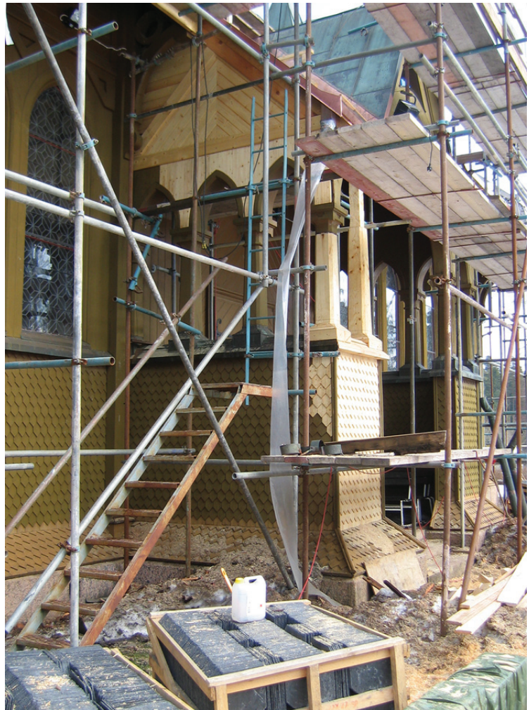
Kompletterande fotplåt. Kortaket med nylagt skiffer, det nya skiffret blir med automatik skarpare i kanterna än det omlagda skiffret.
