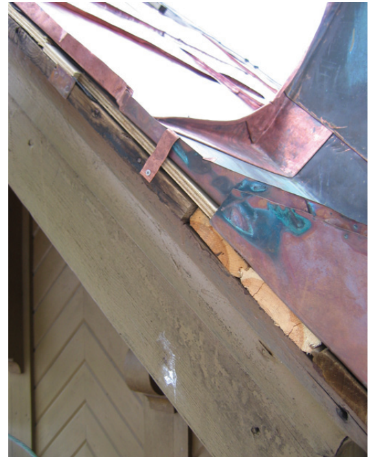
Detalj takbotten med några bytta panelbrädor, kompletterande plywood och takpapp.
