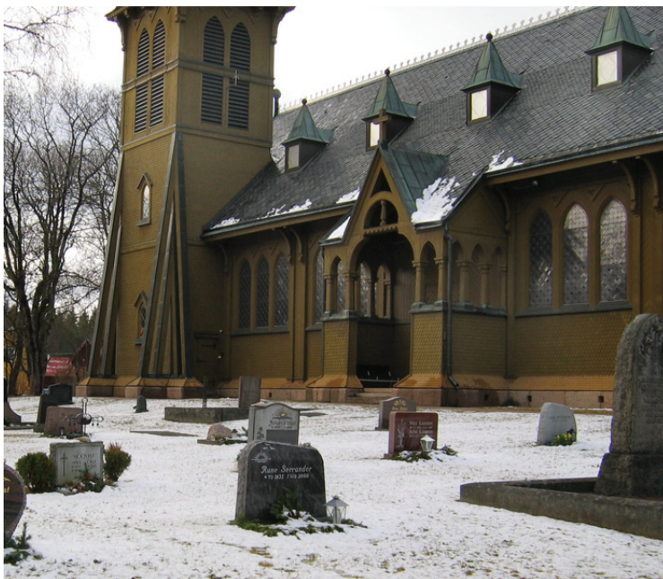
Kyrkan före åtgärd, från sydöst.
