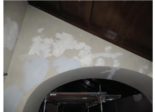
Spacklade sprickor i södra valvbågen mot läktare.
