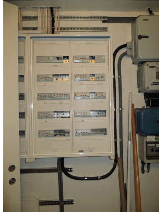
Den ombyggda elcentralen.
