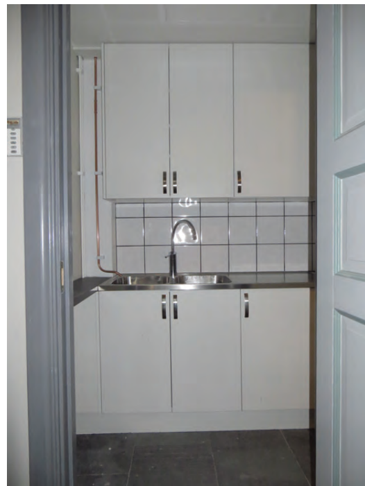
Ett pentry inreddes i tidigare förråd i anslutning till elcentralen.
