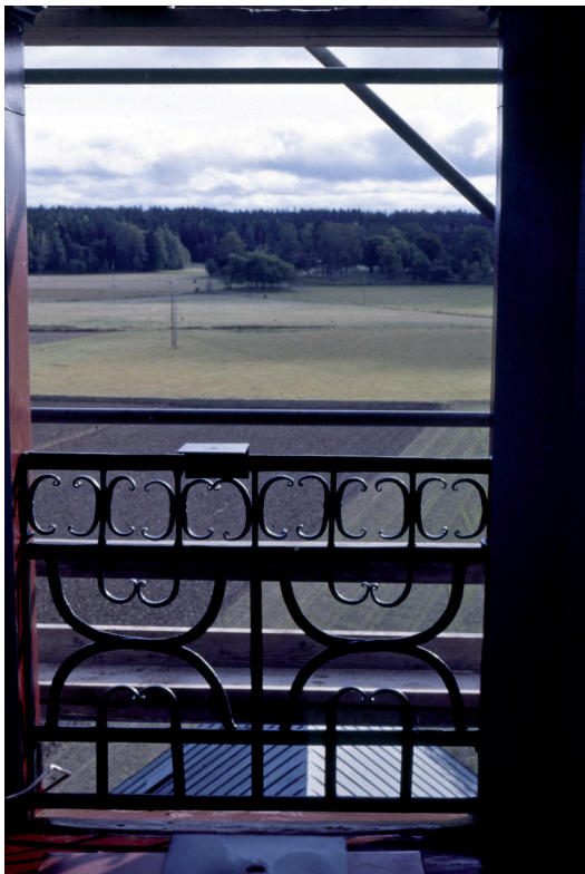
De smidda gallren i lanterninen nedmonterades för blästring och rostskyddsbehandling samt målades med svart linoljefärg.
