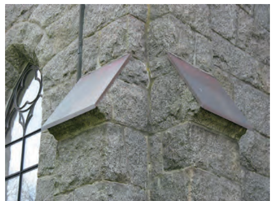
Plåtavtäckning från omkring 1950 på strävpelarna.
