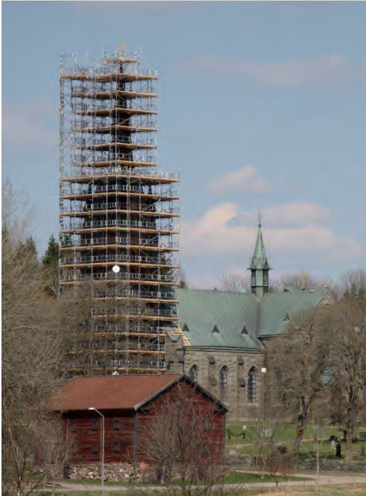
Vallsjö nya kyrkas torn inklätt med byggnadsställningar, maj 2013. Omfogning och översyn plåt.
