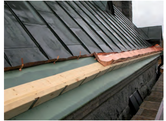
Ovan och till vänster: montering av nya ståldrännor.
