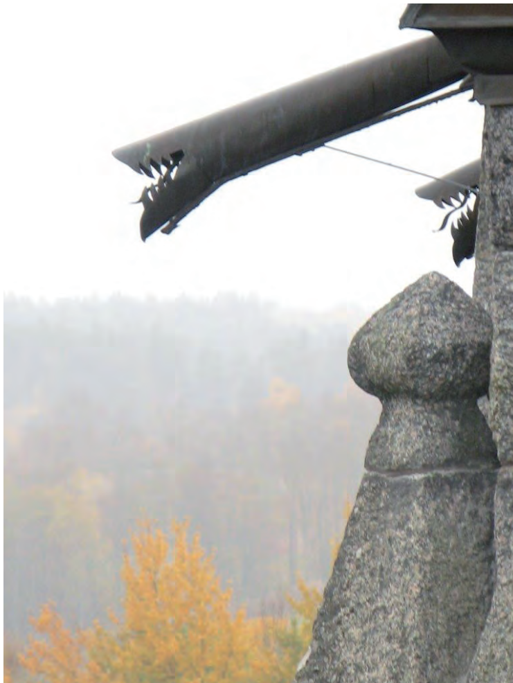
Drakformade utkastare och omfogade samt dubbade fialkrön på tornet.
