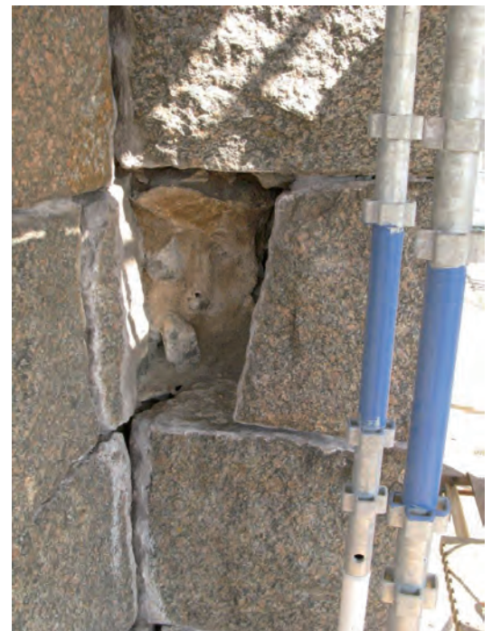
Bortfall av fasadsten på tornet i samband med renhuggning.
