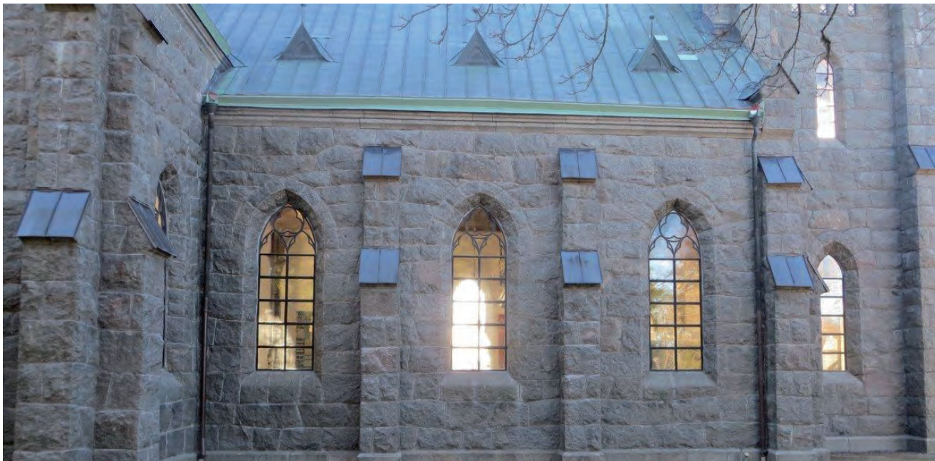
Norra långsidan väster om korsarmen efter avslutade arbeten. Foto: Anders Franzén.
