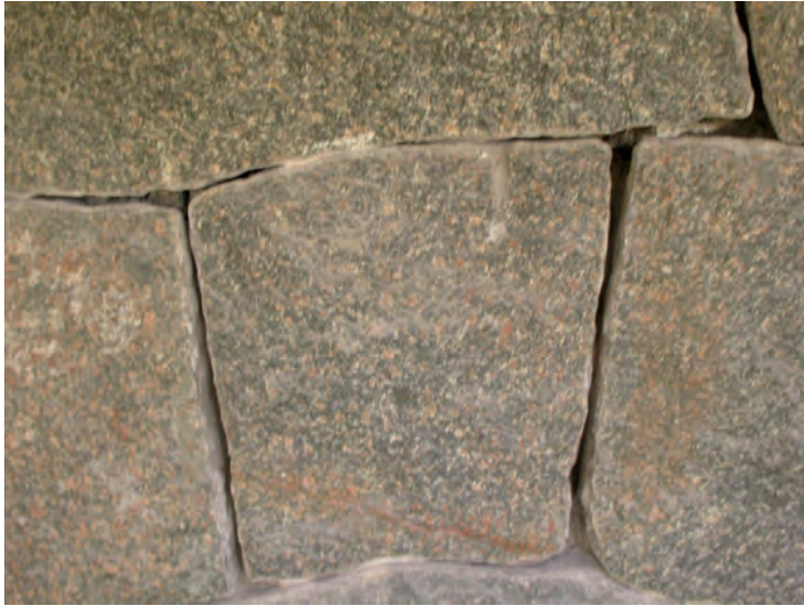
Rensade fogar på parti av tornet, försök att hugga upp för smal fog.
