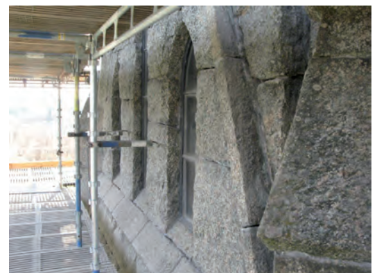
Omfogning pågår på tornet. Två olika kulörer bruk eller är den ena färdig och den andra under arbete?
