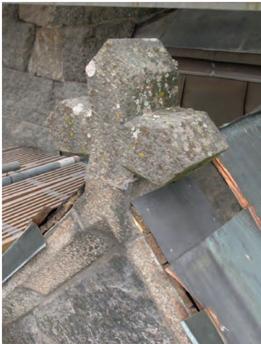
Ovan: ny kopparplåtsavtäckning på strävpelarna (Nordic Brown), här på tornets nordvästra hörn. Alla fogar nygjorda. Till vänster: Kors på vindfång dubbade och omfogade. Ny plåtanslutning under arbete.
