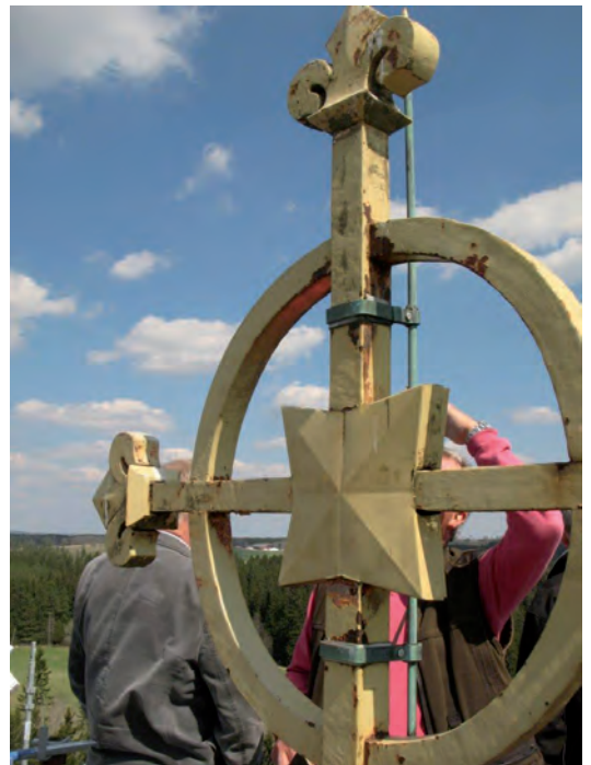
Förgyllningen på tornspirans kors är nästan helt borta.
