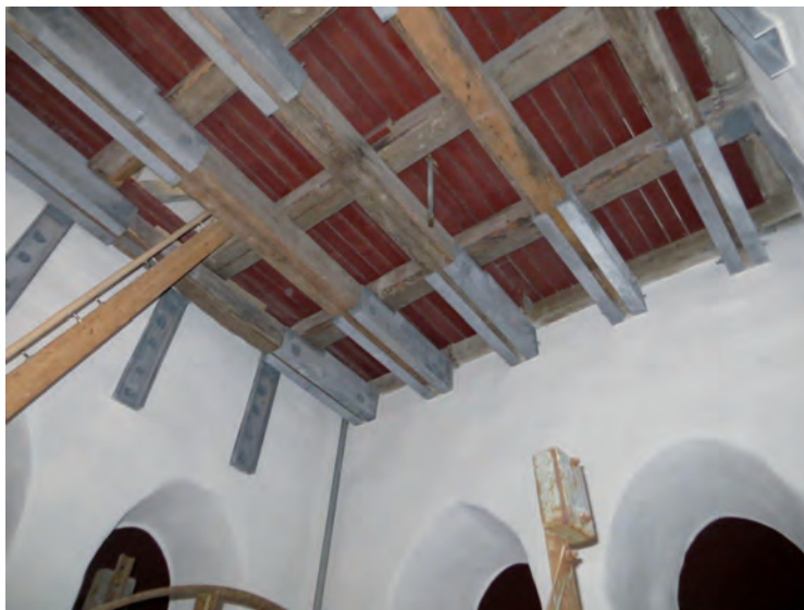
Detalj av tornets klockvåning. Takbjälkar förstärkta. Alla väggar i tornet knackades rena och omputsades samt kalkavfärgades.
