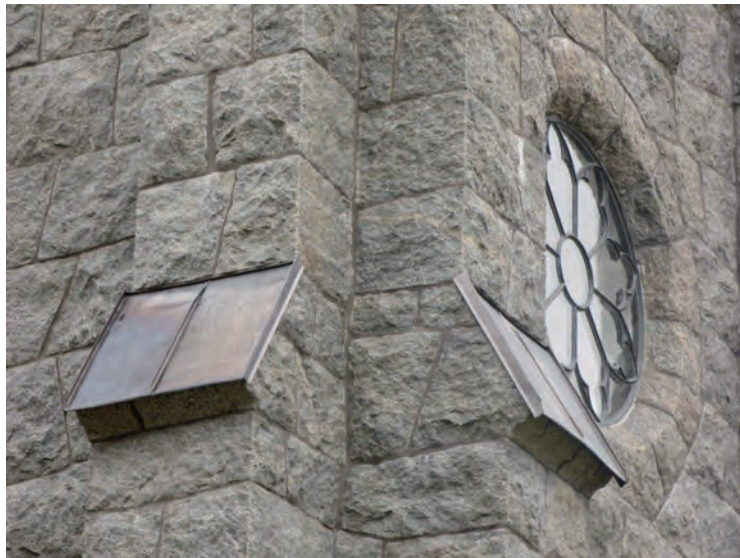
Ovan: ny kopparplåtsavtäckning på strävpelarna (Nordic Brown), här på tornets nordvästra hörn. Alla fogar nygjorda. Till vänster: Kors på vindfång dubbade och omfogade. Ny plåtanslutning under arbete.
