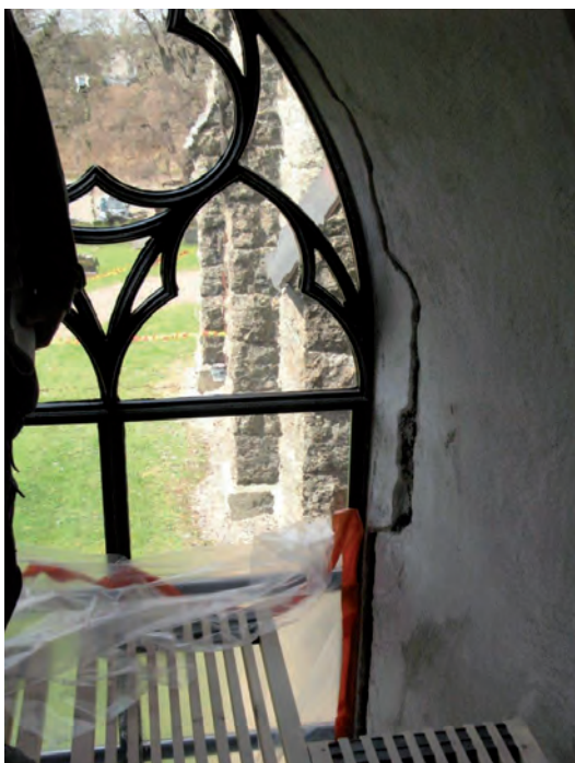
Sprickor i fönstersmygar upphuggna.
