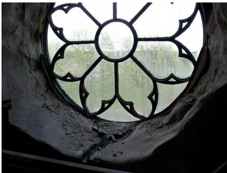
Fuktskador i rosettfönstrets smyg. Foto: Jonas Haas.
