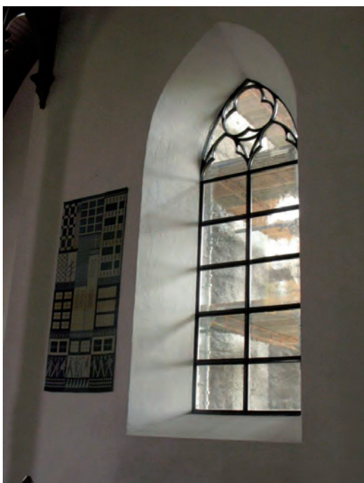
En av fönstersmygarna efter avslutade arbeten.
