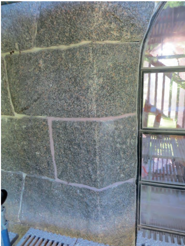
Omfogning pågår på tornet. Två olika kulörer bruk eller är den ena färdig och den andra under arbete?
