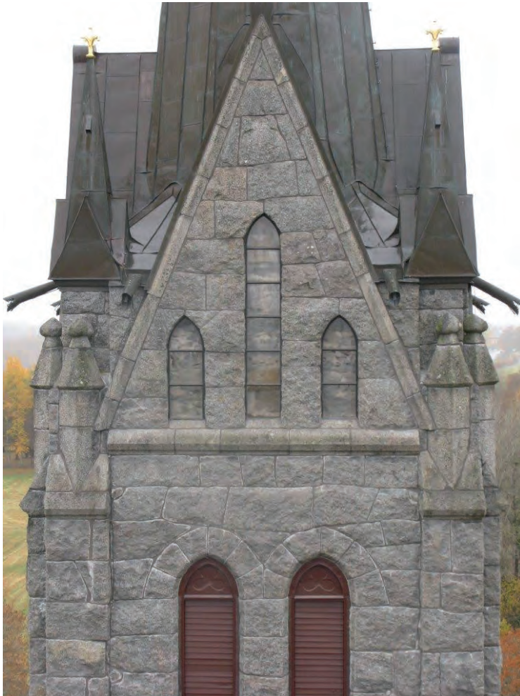
Tornets övre del från öster efter avslutade arbeten.
