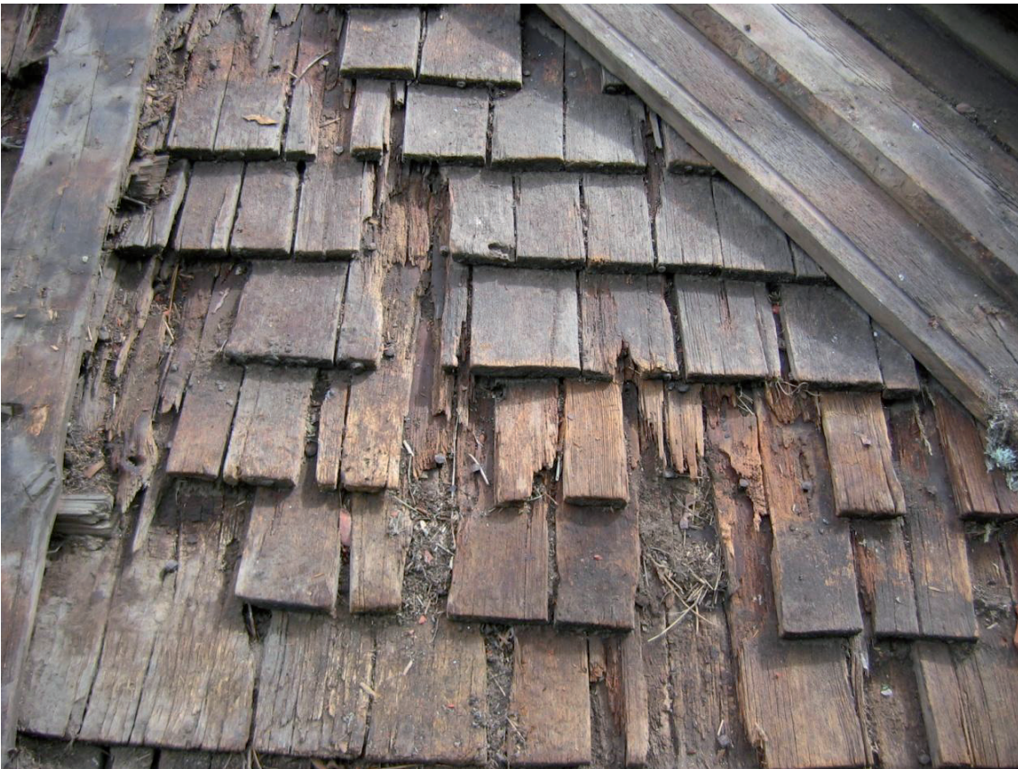
Herrgårdbyggnadens tak från väster. Det underliggande äldre spåntaket. Foto 2005. BEK.
