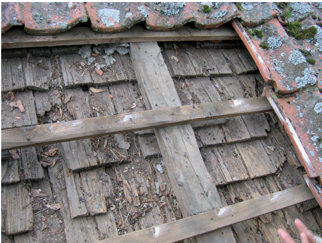
Herrgårdsbyggnaden från öster. Östra takfallet. Det underliggande spåntaket. Foto 2005. BEK.
