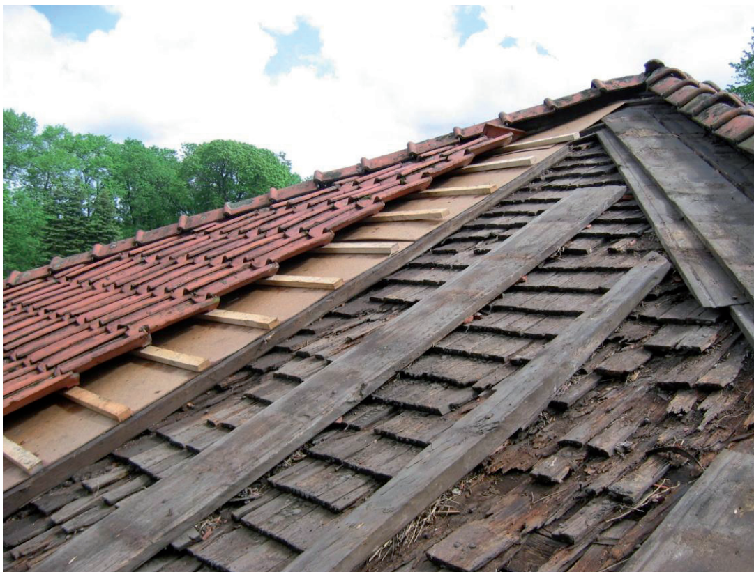
Herrgårdsbyggnaden från sydväst under restaurering. Läggnigen skedde etappvis för att bevara det underliggande äldre spåntaket. Foto 2005. BEK.
