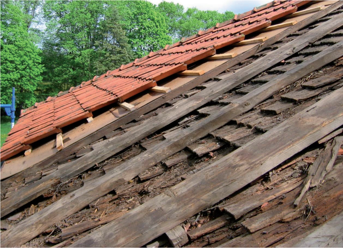
Herrgårdbyggnaden från söder under restaurering. Ny täckning över det äldre spåntaket. Foto 2005. BEK.
