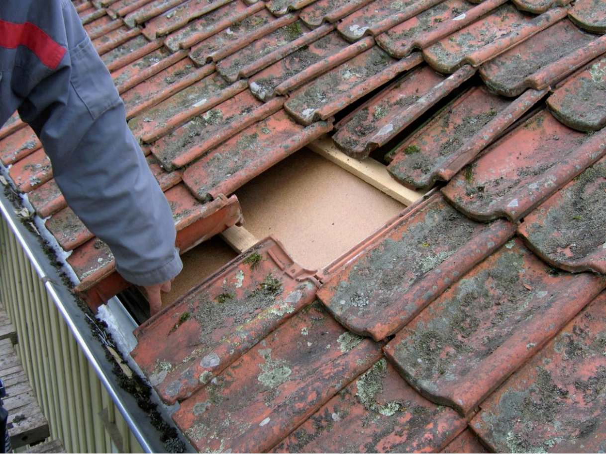
Herrgårdsbyggnaden från öster. Teglet på ny bärläkt och masonit. Foto 2005. BEK.
