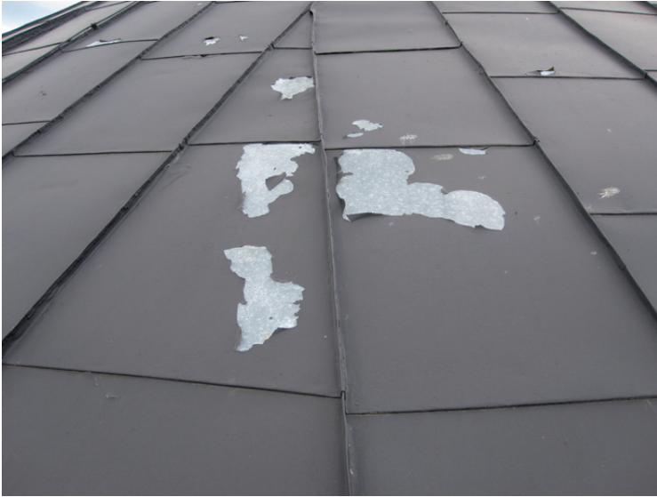
Färgen flagade och lyfte in till plåten.
