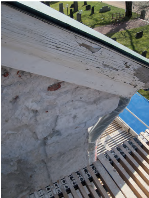
Vattlisterna i koppar vid den västra långhusgavel gjordes om så att de fick en kraftigare droppkant.
