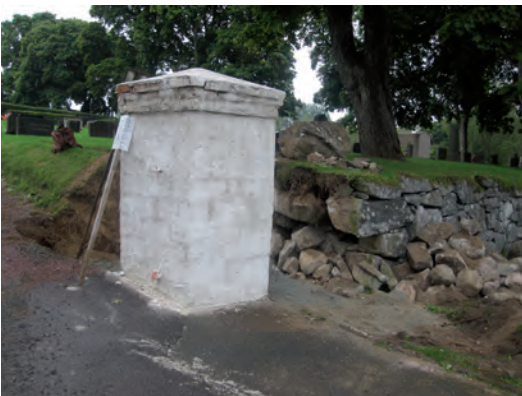
Kyrkogårdsmuren lades om i anslutning till de båda grindstolparna åt väster för att skapa ett mellanrum som hindrar tidigare nedfuktning.
