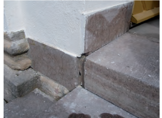
Trappan vid västentrén hade ett övre viloplan som endast omfattade själva dörrnischen. I den nya trappan utvidgades detta plan avsevärt och kom därmed att täcka den ursprungliga sandstensbaserna i portalen.
