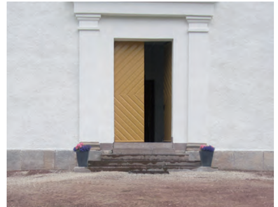
Västingången hade en sentida trappa i röd kalksten. Notera portalens pilasterbaser i huggen sandsten.
