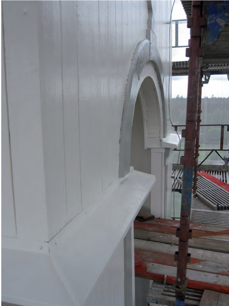
Lanterninen med den justerade färgsättningen som innebär att både de stående markeringarna och den välvda markeringen erhöill grå kulör.
