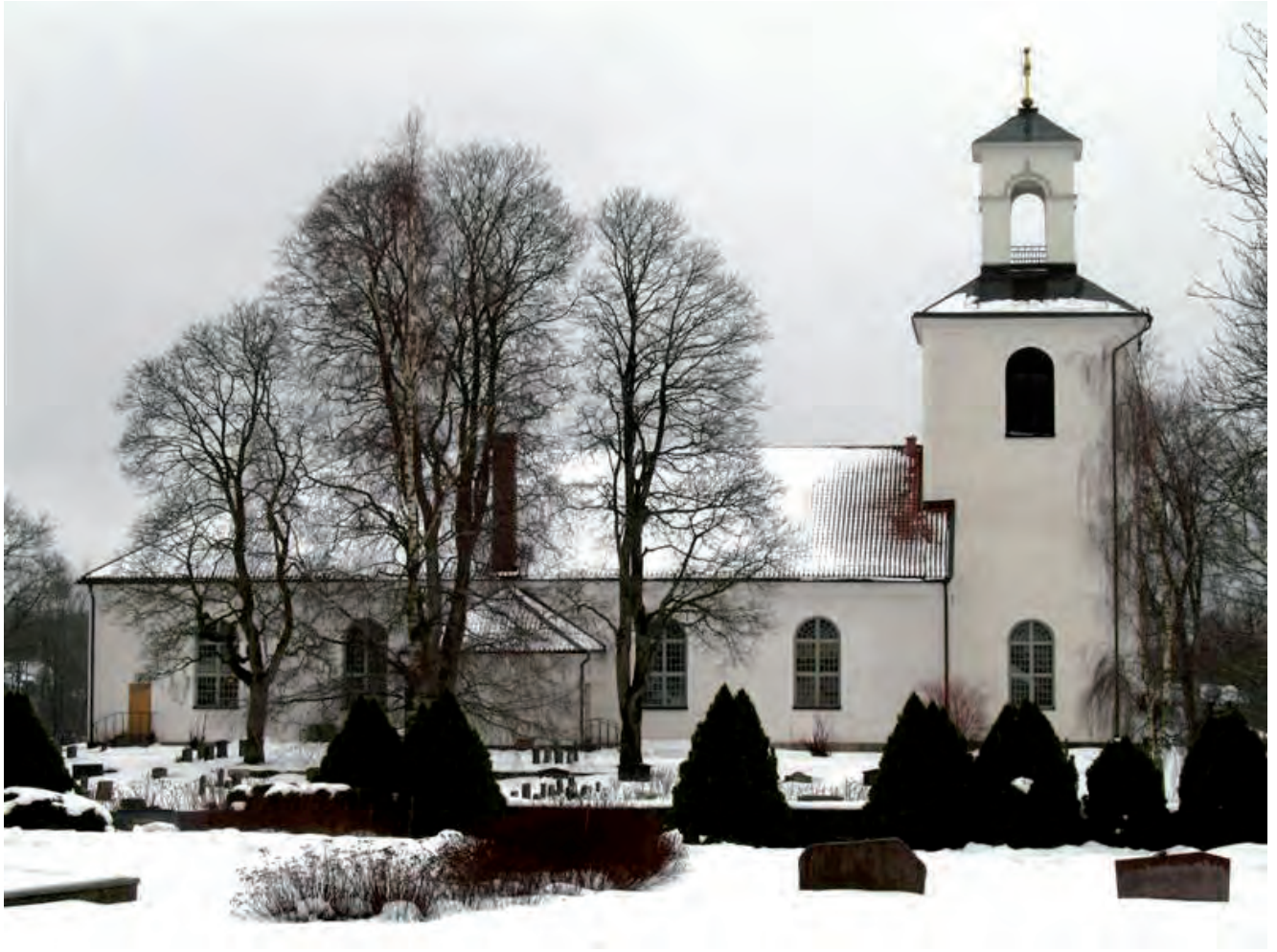
Kyrkan före fasadrenovering. Lanterninens fasaddekor är endast svagt artikulerad.
