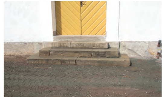
Under den borttagna handikappampen vid sydentrén fanns den ursprungliga trappan kvar. Här före omfogning.
