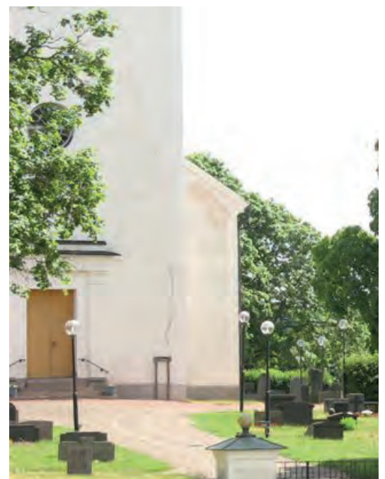
Putsskador förkom på tornets och långhusets västfasader som främst gick att härleda till att putset inte helt karbonatiserat (härdat) vid den föregående renoveringen 1998.
