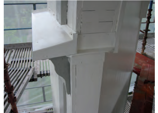
Som komplement till plåten på gesimsen ordnades en plåt i smygen där det fanns otätheter.
