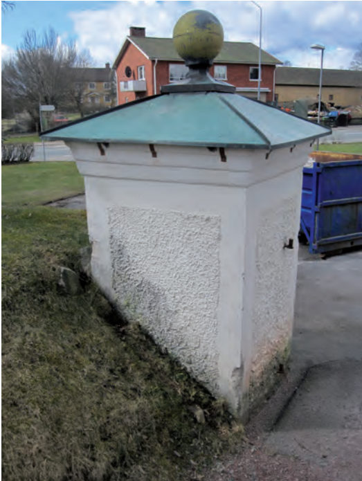
Kyrkogårdsmuren med tillhörande slänt slöt dikt an mot grindstolparna vid den västra porten, något som orsakat fuktproblem och missfärgningar på stolparna.
