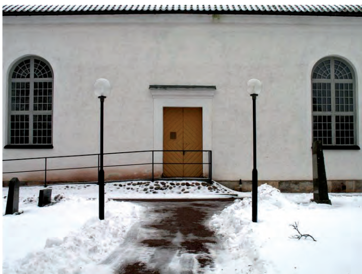
Framför sydentrén finns en sentida ramp för rörelsehindrade. Rampen har orsakat en kraftig missfärgning av fasaden.
