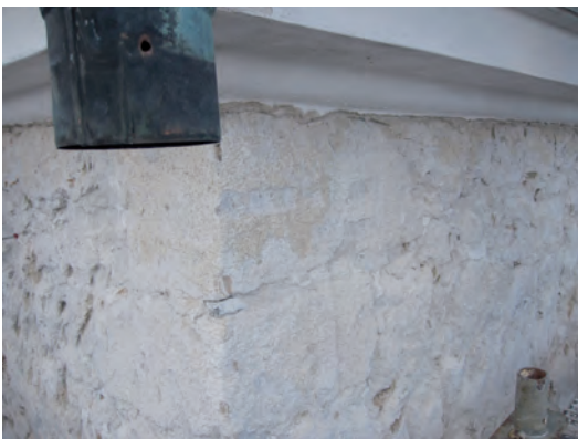
Del av tornfasaden efter att putsen knackats ned. Murverket innehöll hörnkedjor av huggen sandsten?
