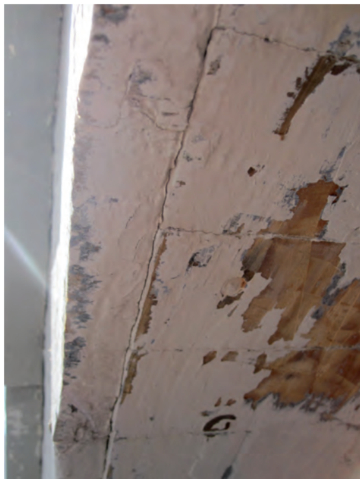
Vid skrapningen av tornlanterninen framkom att den invändigt samt i den rundbågiga öppningen i äldre tider varit målad i gråa och blå nyanser. De yttre färgskikten strax under dagens vita var ljusare gråblå medan de undre var mörkblå. Fotografier av kyrkan 1909 visar att hela lanterninen då hade en färgställning i mörkare mer mättade kulörer.
