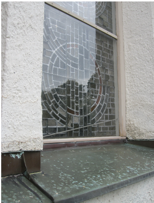
Ett av fönstren mot sydväst med ett sekundärt stag som lossnat och lagts sig i botten av fönstret.
