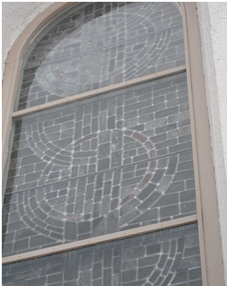
Ett av fönstren mot sydväst med ett sekundärt stag som lossnat och lagts sig i botten av fönstret.
