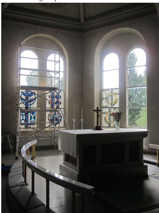
Nedan: Arbetena genomfördes i tre etapper där 1/3 av kassetterna togs in på verkstaden.
