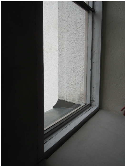
Ovan: Här har den inre blyglaskassetten demonterats för åtgärder på verkstaden.
