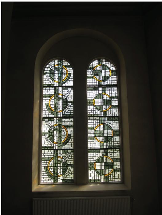
Det vänstra (inifrån sett) sidofönstret i koret inför arbetena.
