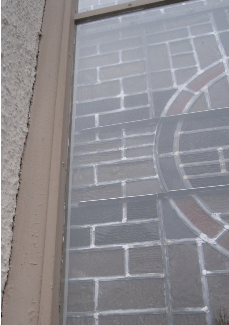
Ovan: Sidofönster efter restaurering. Övan till vänster: De nya stagen som dragits och fästs vid strategiska punkter, men når inte ända fram till kassettkanterna. Nedan till vänster: Koret med fönsterna vid slutbesiktningen.
