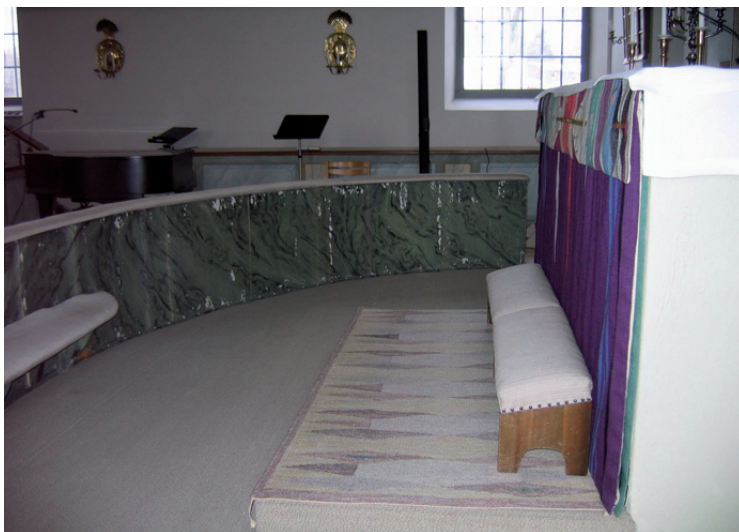
Altarringen före åtgärd, den grönmarmorerade insidan av rundeln hade kraftiga spjälkningar, golvet var täckt av en heltäckningsmatta.
