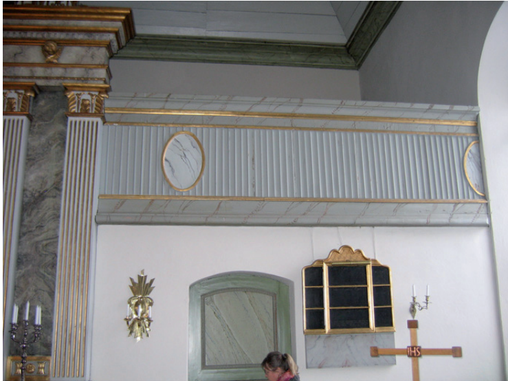
Korläktarbröstning söder, före åtgärd.
