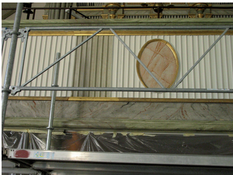
Orgelläktarbröset under pågående arbete.
