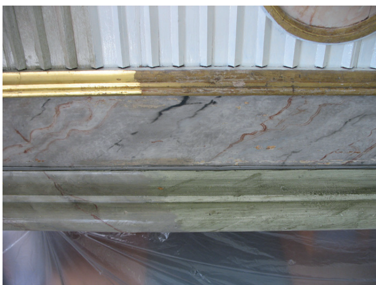
Orgelläktaren hade ett något annat färgschema än korläktaren. Det gråmarmorade partiet lämnades i princip orört, endast smärre retuscher gjordes. Den gröna listen tonades ned för att bättre stämma mot övriga partier. Provyta med omförgyllning och färgsättning.
