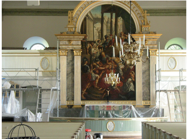
Pågående arbeten på korläktarbröstet, grundering är vid besiktningstillfället lagd på stora delar av ytan.
