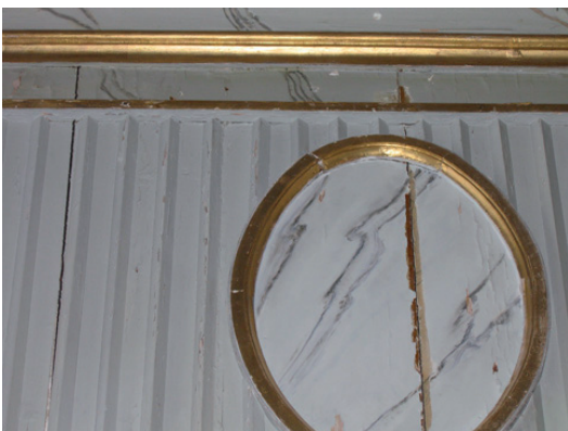
Detalj, korläktarbrösten före åtgärd.
