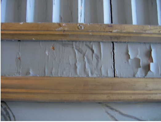
Vissa ytor uppvisade kraftiga spjälkningskador.
