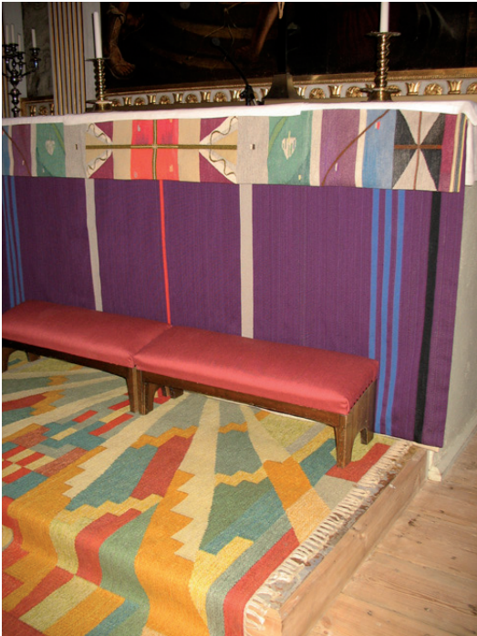
Podiet med de återanvända bemålade brädorna framför altaret lämnas utan åtgärd.
