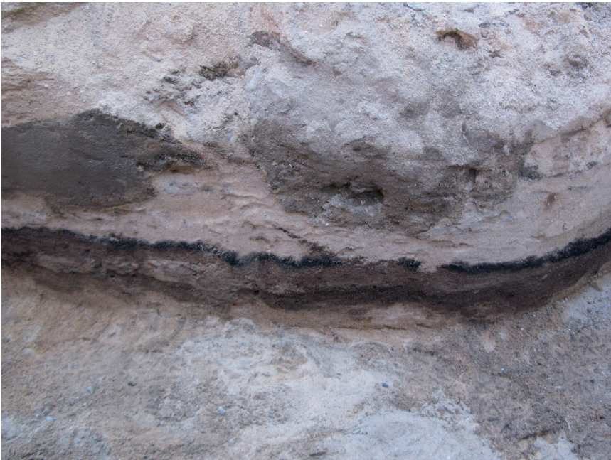
FIGUR 4. Mellersta delen av brandlager, södra profilväggen, öst-västligt schakt i västra innergården. Foto från norr av Rickard Wennerberg. Digitalbild nr 23.
