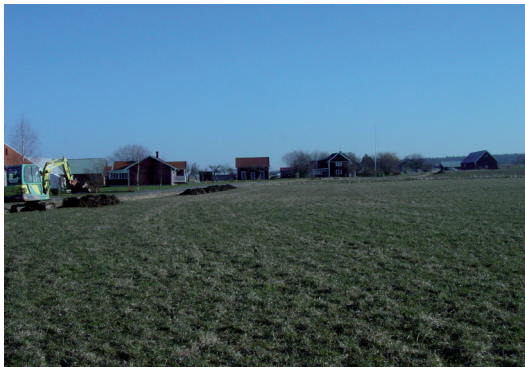
Figur 3. Schaktningsarbete i Husgårde. Foto: Anna Ödeén.
