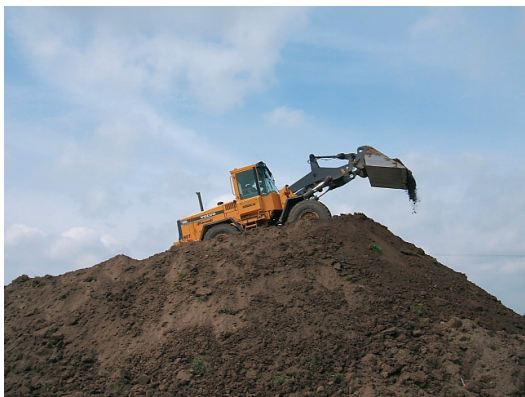
FIGUR 5. Jordmassor dumpas på hög med hjullastare. Foto: Max Magnusson.
