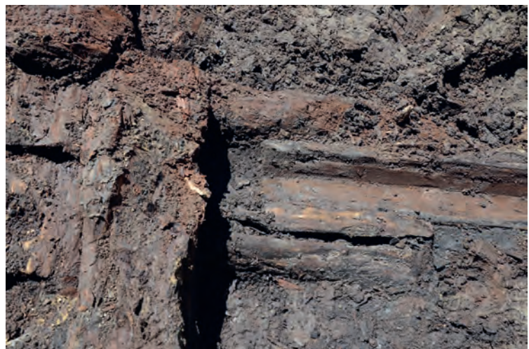
FIGUR 42. Detaljfoto på rännan. Här syns avslutningen av rännan strax innan väggkonstruktionen. Rännan har alltså inte varit ursprunglig i väggkonstruktionen och hörnet. Foto från norr.
