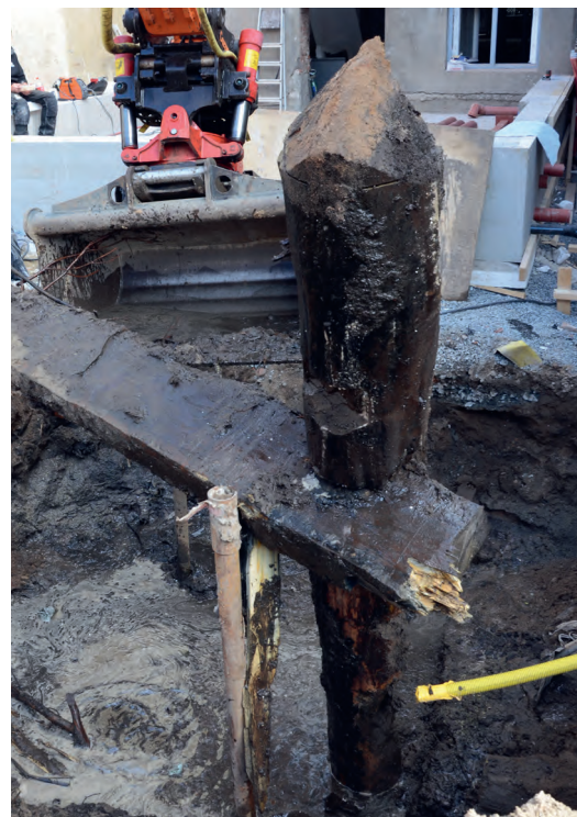
FIGUR 48. Efterundersökning av ett hisschakt inom tomt 21, då komplettering gjordes av grundkonstruktionen av timmerkistan. Här dras den nord-sydliga stocken upp. Denna konstruktion har varit sammanbyggd med stockar som daterats till i provet P 2732.
