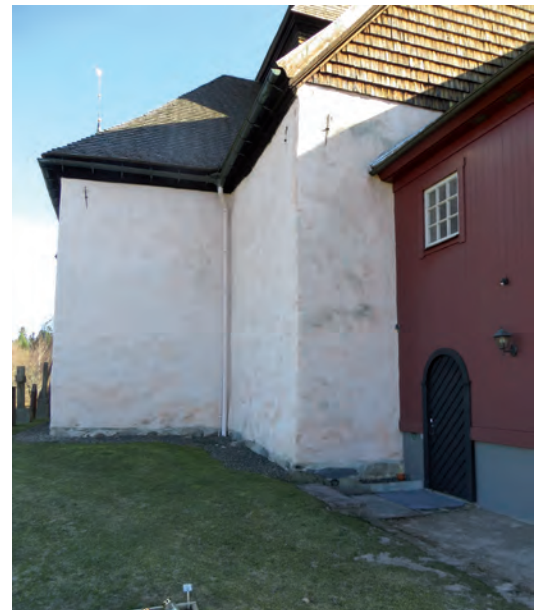
Ovan: Putsskador inför arbetena. Till vänster: Den norra fasaden inför restaureringen. Nedan: Kyrkobyggnadens nordvästra delar och vapenhusets källaringång inför arbetena.
