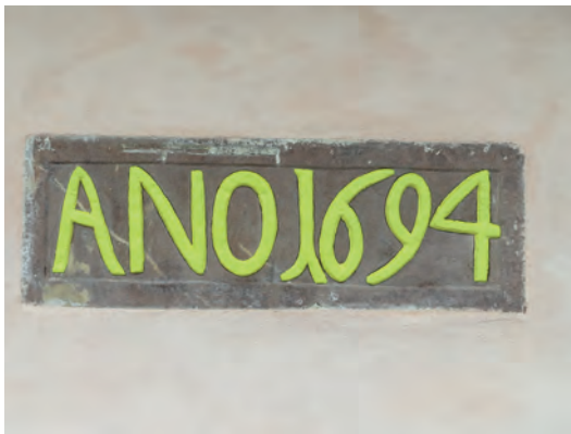
Det mesta av tavlans röda färg gick förlorad vid rengöringen. Imålning skedde med linoljefärg i befintlig kulör.
