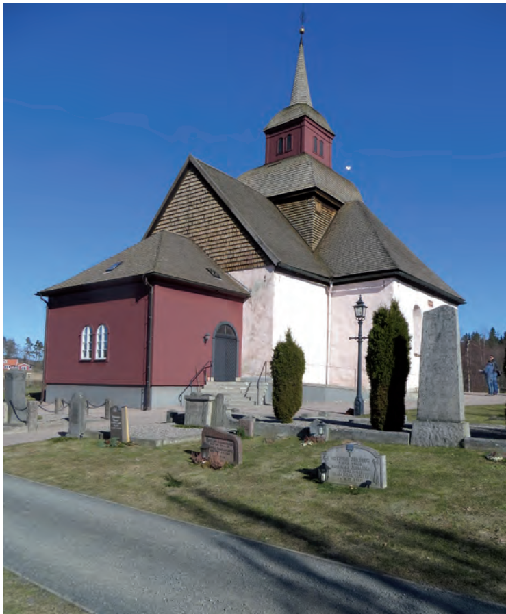
Kyrkobyggnaden sedd från sydväst inför arbetena.
