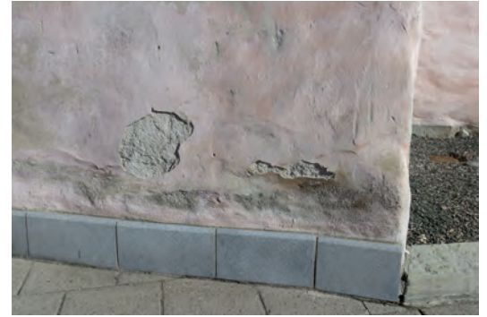
Ovan: Putsskador inför arbetena. Till vänster: Den norra fasaden inför restaureringen. Nedan: Kyrkobyggnadens nordvästra delar och vapenhusets källaringång inför arbetena.
