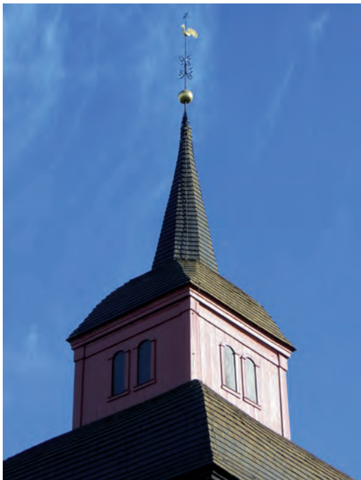
Takryttaren efter tjärstrykningen och ommålningen.
