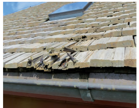
Ovan: Spåntaket på vapenhuset hade partiella rötskador inför arbetena. Till vänster: Kalkstensmaterialet vid huvudingången var vittrat trots att den uppfördes så sent som 1994.
