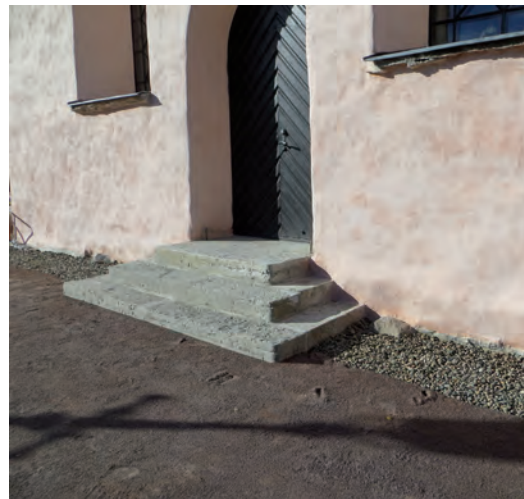
Den södra ingångens trappa efter omläggning och konservering.
