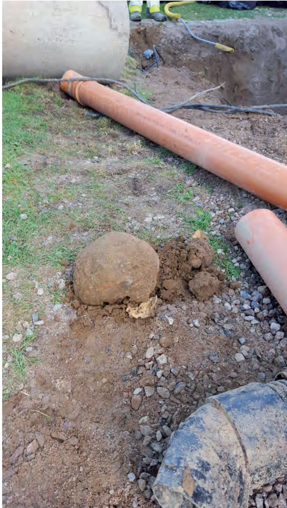
UPPHITTAT Kranium i befintlig ledningsbädd längst västra fasaden.
