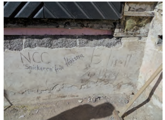
Vid rivningen av vapenhusets trappa framkom skrivna hälsningar från de som var inblandade vid uppförandet 1994 (NCC, "Snickaren från Hössna" och B Tisell).
