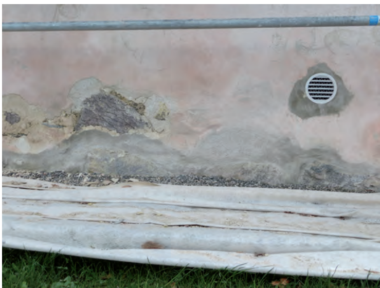
Ovan: Delar av fasaden hade bortfall i form av äggskalsliknande skikt av ytputs.
