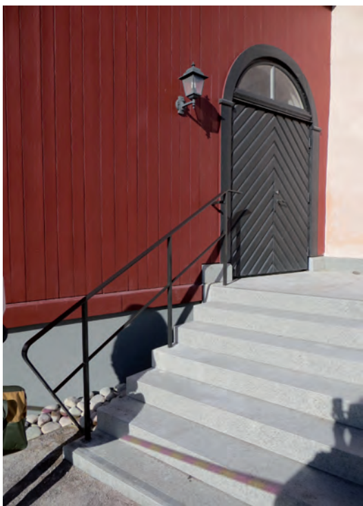
Ovan: Den nya trappan med räcket monterat och målat. Till höger: Den nya trappan och rampen av granit.
