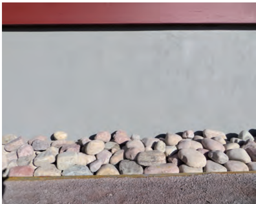
För att undvika fuktvandring lades ett band av stora stenar utefter vapenhusets sockel. Mot gången avgränsades detta med ett stålband.
