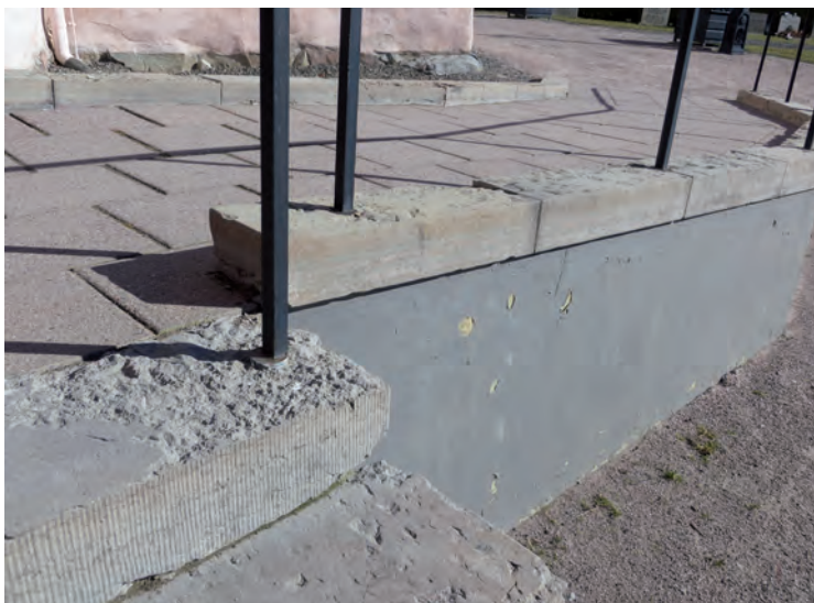
Ovan: Spåntaket på vapenhuset hade partiella rötskador inför arbetena. Till vänster: Kalkstensmaterialet vid huvudingången var vittrat trots att den uppfördes så sent som 1994.
