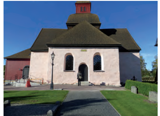
Kyrkans södra fasad vid slutbesiktningen.
