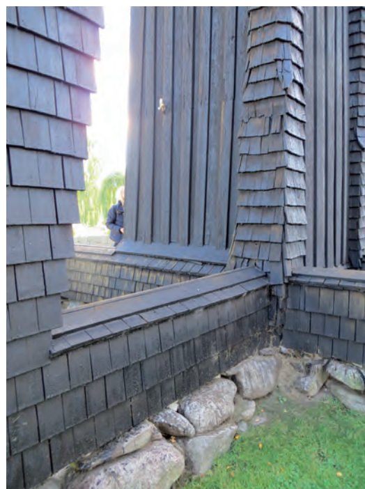
Ovan: Klockstapelns spånytor ströks med dalbränd trätjära.
