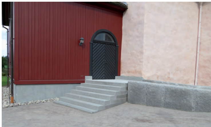
Ovan: Den nya trappan med räcket monterat och målat. Till höger: Den nya trappan och rampen av granit.
