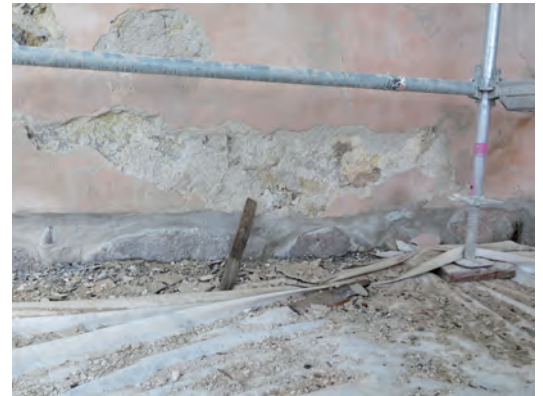
Ovan: Putsskadorna var särskilt omfattande nedtill på fasaderna.
