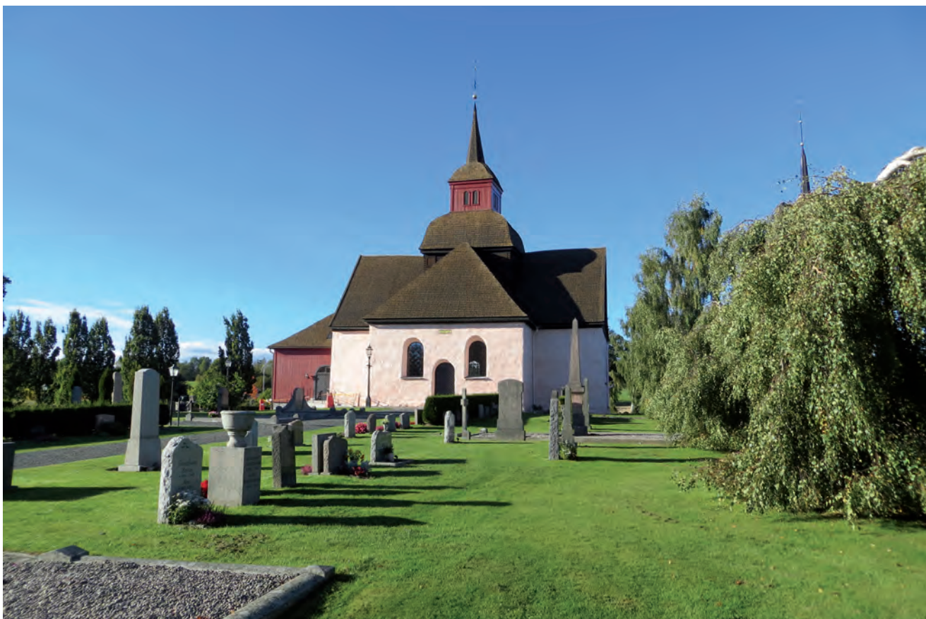
Hakarps kyrka efter avslutade arbeten.
