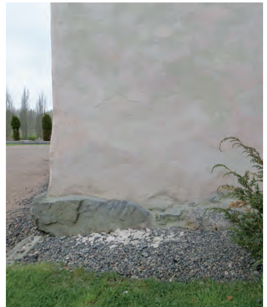
Ovan: Delar av fasaden hade bortfall i form av äggskalsliknande skikt av ytputs.
