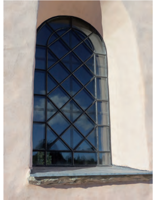
Fönstren med järnbågar skulle i princip endast underhållsmålas med svart linoljefärg.
