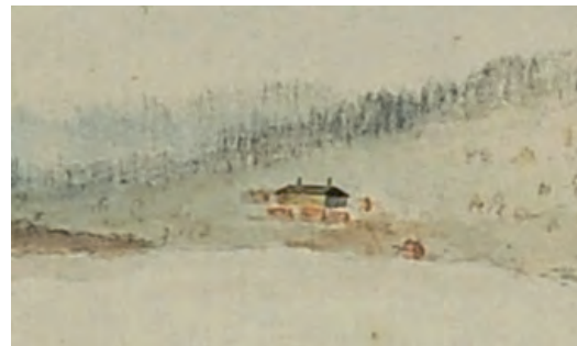
FIGUR 10 Rosenlunds herrgård sommaren 1790. Notera de framförliggande byggnaderna. Detalj hämtad ur akvarell av Jonas Carl Linnerhielm. Tillhör Jönköpings läns museum..
