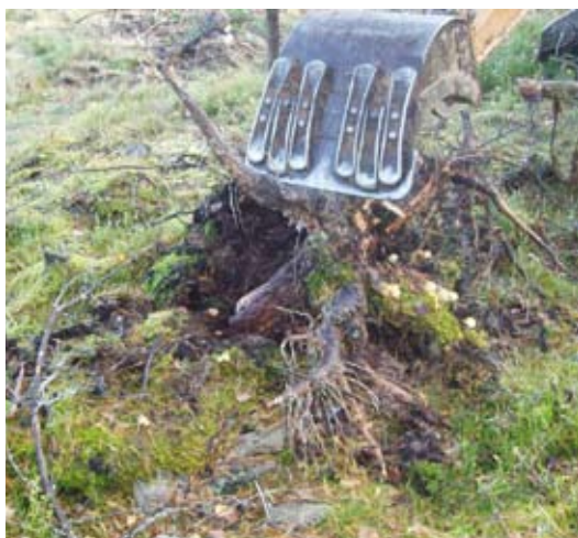
FIGUR 29. Rotvålta 5 under borttagande.
