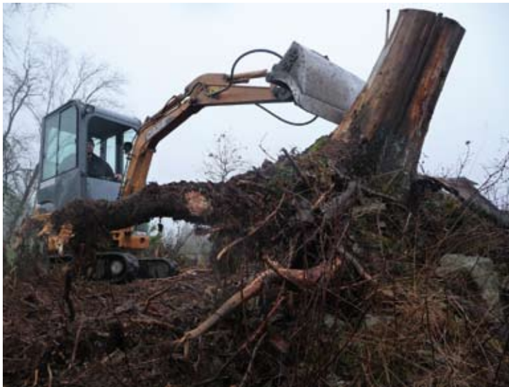
FIGUR 217. Rotvälja 3 avlägsnas med minigrävare, som visat sig vara ett ovärderligt och kraftfullt redskap i svår terräng.
