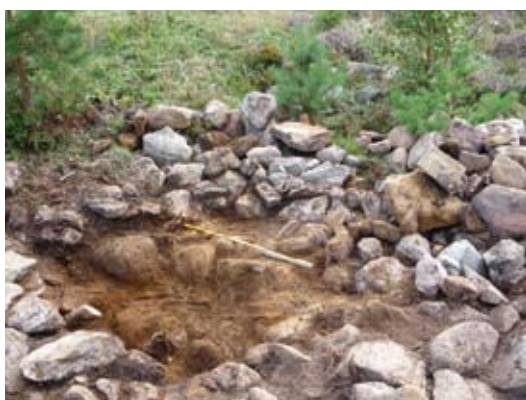
FIGUR 57. Rotvältan borttagen och skadan rensad. De stenar som rubbats av vältan lades upp runtom skadan.
