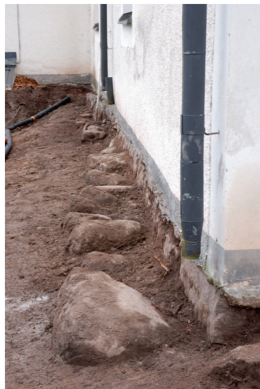
FIGUR 3-4. Detalj av grundmuren. Foto från väster respektive öster.
