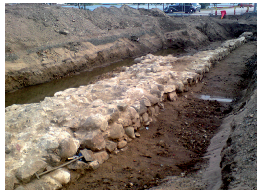
FIGUR 5. Kurtinmuren. Jönköpings slotts befästning på sjösidan. Undersökning på blivande Magnus Ladulås plats år 2007. Foto : Stefan Pettersson.
